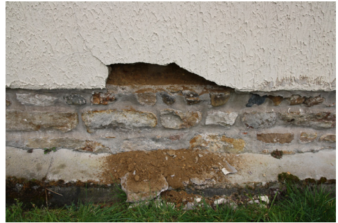
⤴ Fissure horizontale à la limite avec le soubassement. Enduit ciment très épais, sonne creux. Pisé trempé sous l'enduit, Préconisation de sondage supplémentaire avec découpe d'enduit.
