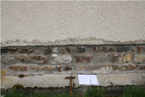
⤴ Fissure horizontale à la limite avec le soubassement. Enduit ciment très épais, sonne creux. Pisé trempé sous l'enduit, Préconisation de sondage supplémentaire avec découpe d'enduit.
