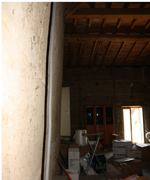
⬆ Basculement du mur de refend et du mur pignon vers l'Ouest, calé à l'extérieur par un bâti
