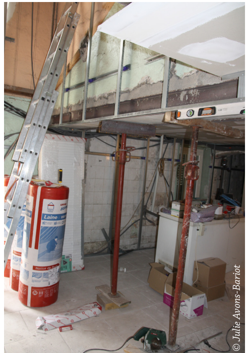
⤴ Mur de refend déstabilisé par la réalisation d'une grande ouverture en sous-oeuvre avec un défaut de blocage au niveau de l'IPN.
