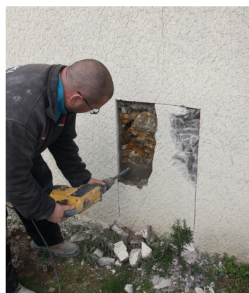
⬆ Diagnostic pour une pathologie spécifique Saint Lager (69) - Façade Ouest fissurée à l'origine de la demande d'intervention - Réalisation d'un sondage par un maçon (2ème visite)
