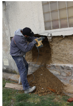
⤴ 2ème visite avec le maçon : Découpe de l'enduit et réalisation d'une reprise en sous-œuvre dans la partie la plus dégradée
