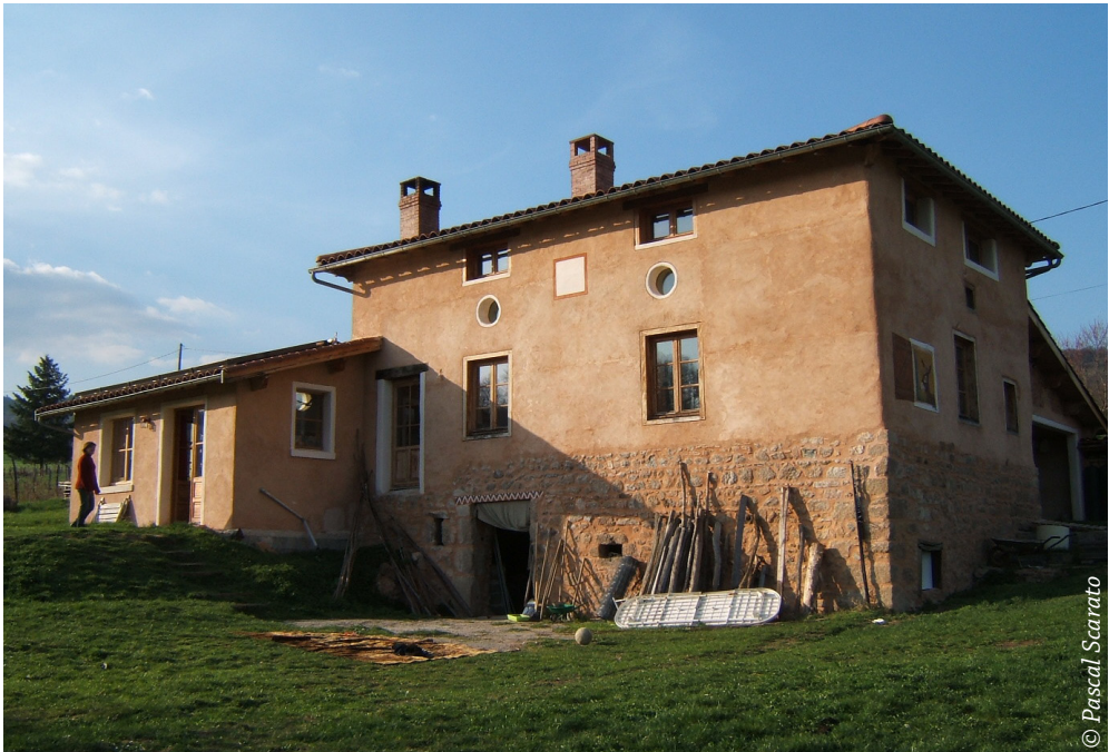
↑ Réhabilitation réalisée par Abiterre - Montrottier (69)
