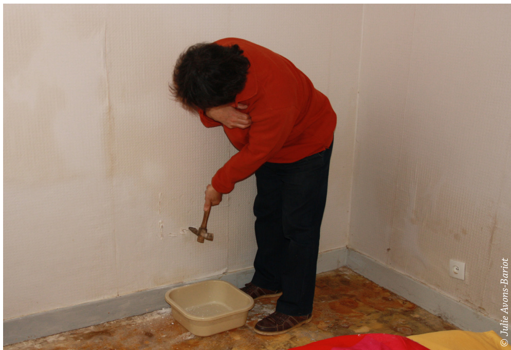
⤴ Réalisation d'un sondage au marteau lors d'un diagnostic. Sondage possible lorsque le revêtement n'est pas trop dur, ni trop épais.
