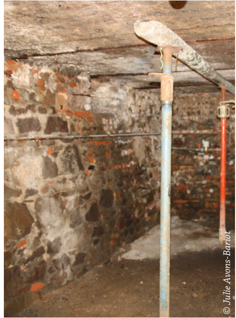
⤴ Les IPN de la dalle de la cave du bâtiment rasé endommagés par les infiltrations.
