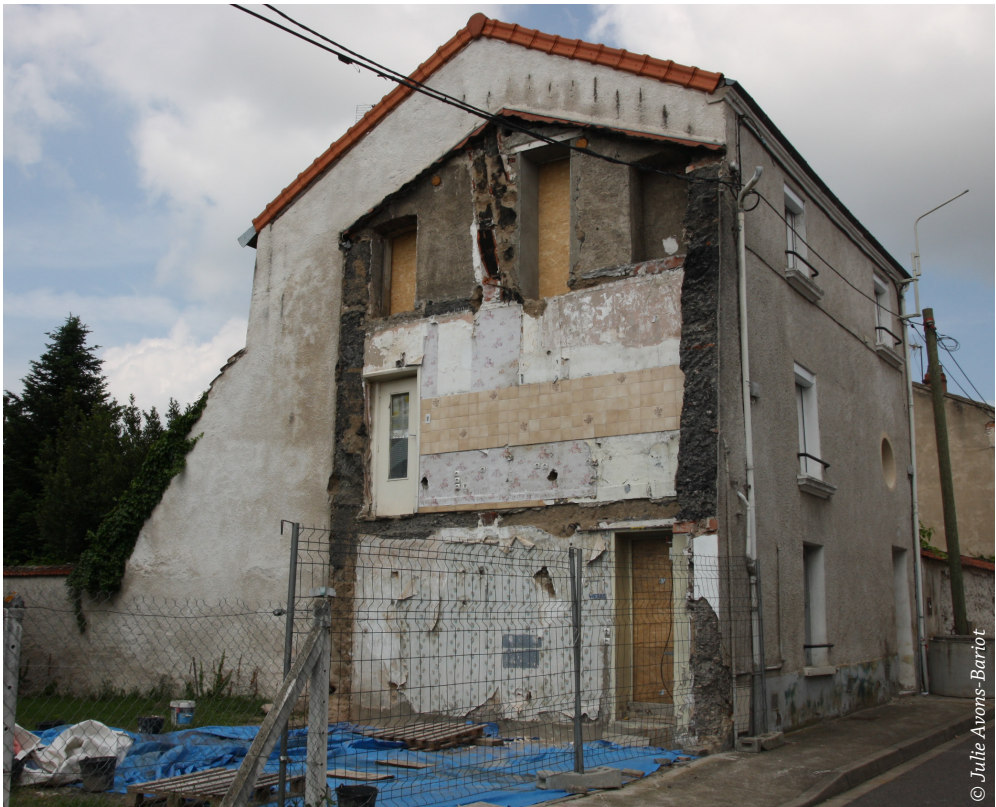
↑ Le bâtiment à expertiser a été démoli suite à l'arrêt de péril.
