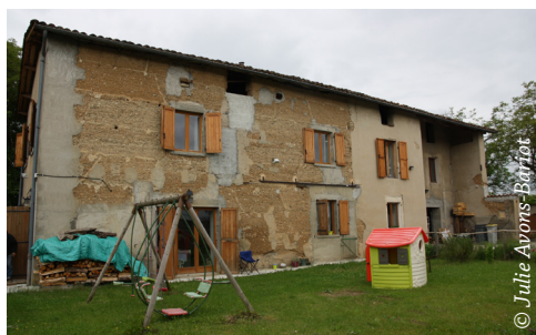
⤴ Diagnostic avant travaux - Bourgoin Jallieu (38)
