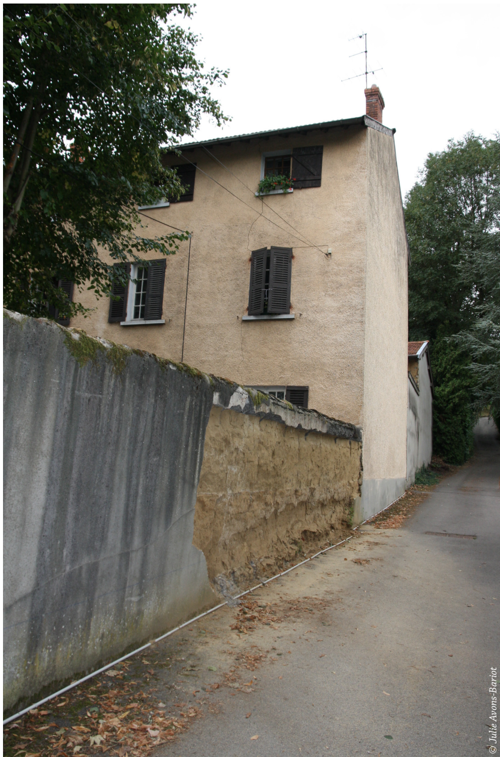
⬆ Expertise judiciaire - dégradation du mur par rehausses. - Saint Cyr au mont d'Or (69)
