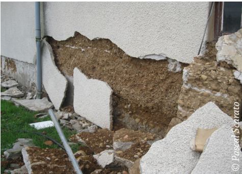
⬆️ Détail pied de mur Nord - Soubassement en maçonnerie de galets de 30cm.
