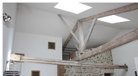
⬆ Anciens tirants répercutants le basculement sur les autres murs de refends
