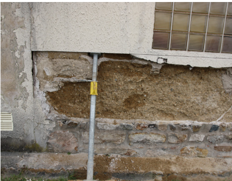
⤴ 2ème visite avec le maçon : Découpe de l'enduit et réalisation d'une reprise en sous-œuvre dans la partie la plus dégradée
