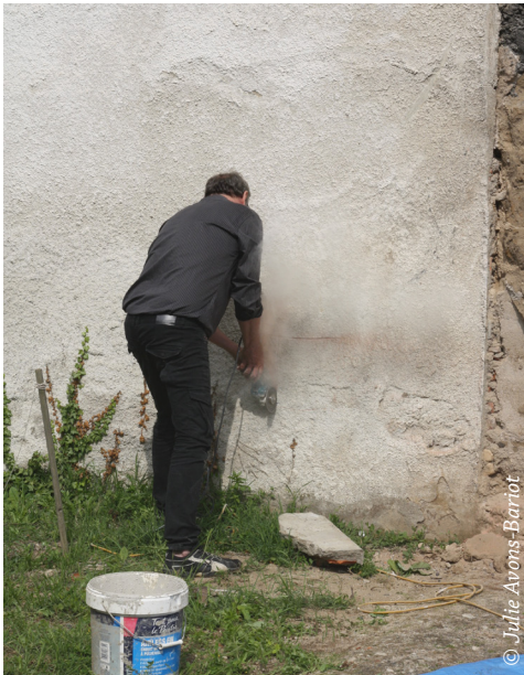
Ⓜ Réalisation d'un sondage : 1ère découpe à la disqueuse. Présence d'une reprise sous l'enduit.
