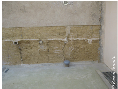
⤴ Soubassement maçonné non visible lors des sondages
