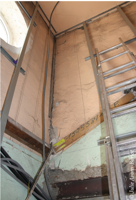
⤴ Mur de refend déstabilisé par la réalisation d'une grande ouverture en sous-oeuvre avec un défaut de blocage au niveau de l'IPN.
