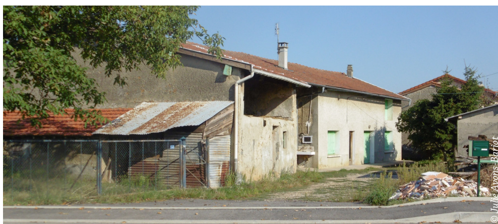
⤴ Diagnostic avant travaux - Façade Est et Sud des bâtiments - St Bonnet de Mure (69)
