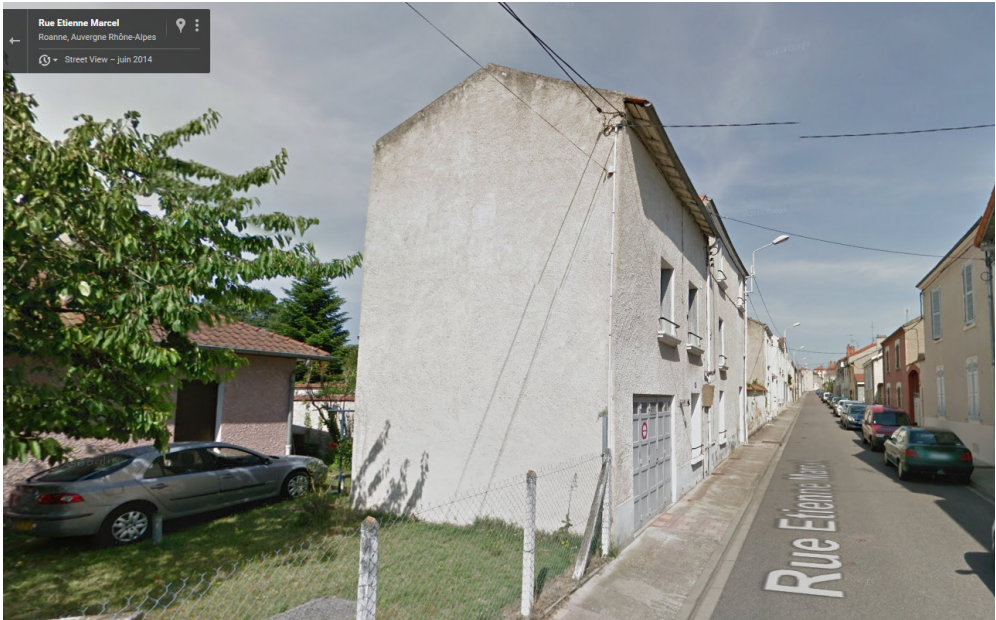
↑ Photographie Google Map -Le bâtiment avant sinistre
