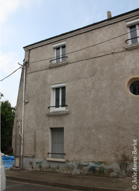
⤴ Enduit décollé et fissuré sur la façade sur rue.
