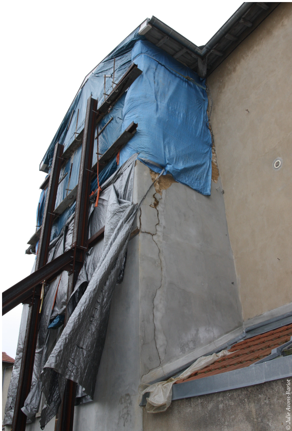
↑ Étaie d'une façade en pisé dans le cadre d'un expertise judiciaire - mission en référés précédée d'une mission urgence. Champagne au Mont d'or (69).
