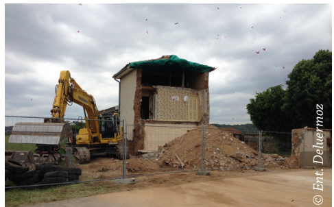
↑ Travaux de déconstruction - mai 2014.
