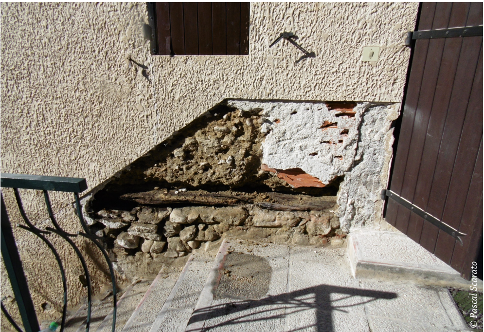
↑ Mur Sud Est : pisé humide, friable, et bois d'un ancien linteau pourris.
