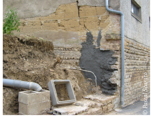
⤴ Avant remblai et construction du mur de soutènement
