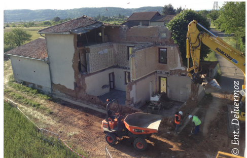
↑ Travaux de déconstruction - mai 2014.
