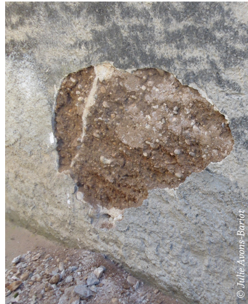
⬆ Façade Nord avec enduit chaux, banquette béton, faiblesse du soubassement et pisé dégradé
