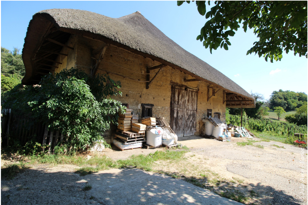
⤴ Grange Louisias à Charavines (38) - classée Monument historique, mais souffrant aujourd'hui d'une pathologie liée à la rehausse du terrain.
