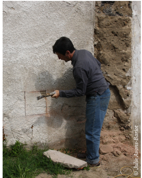
Ⓜ Réalisation d'un sondage : 1ère découpe à la disqueuse. Présence d'une reprise sous l'enduit.
