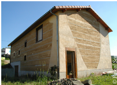
⤴ Construction d'une habitation en pisé - Romagnat (63)
