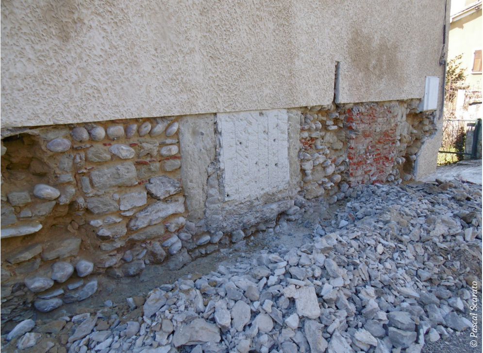
↑ Hétérogénéité des matériaux due à des reprises du pisé dégradé. Un point d'alerte pour le maçon.
