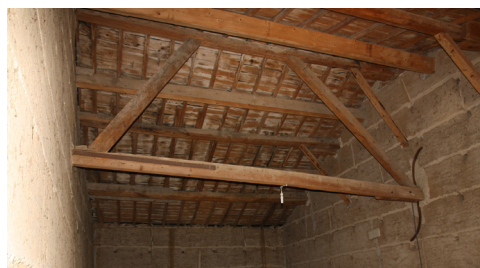
⬆ Anciens tirants répercutants le basculement sur les autres murs de refends
