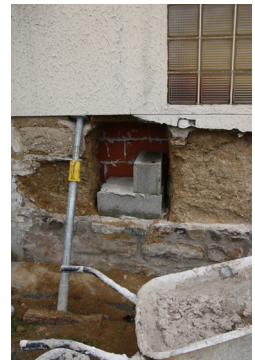
⤴ 2ème visite avec le maçon : Découpe de l'enduit et réalisation d'une reprise en sous-œuvre dans la partie la plus dégradée
