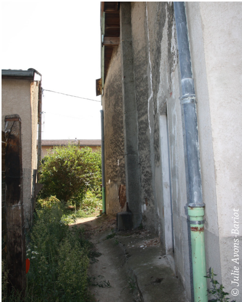
⬆ Façade Nord avec enduit chaux, banquette béton, faiblesse du soubassement et pisé dégradé
