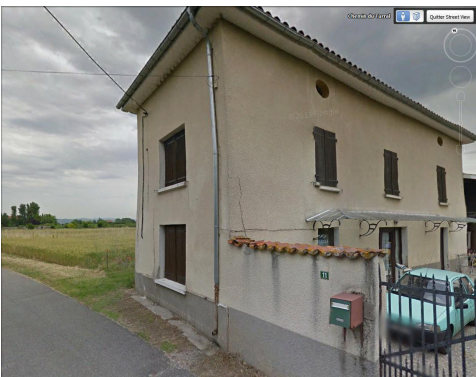
↑ Photographie Google Earth 2013 - Façade Sud.
