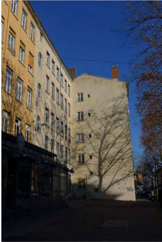
Selon A-S. Cléménçon, ce mur pignon est en pisé de terre (Secteur UNESCO, blv de la Croix-Rousse, Lyon 4 e ). Photo : A-S. Cléménçon
