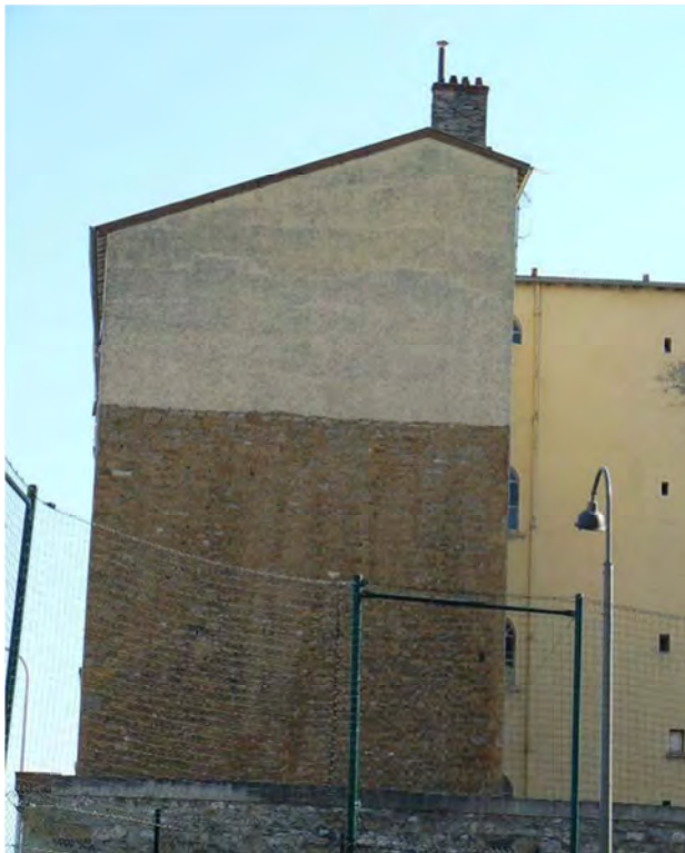
Mur pignon d'un immeuble canut dans le quartier de la Croix Rousse (rue Thévenet, Lyon 4 e ). Si la partie basse est en pierre, qu'en est-il de la partie haute dont la maçonnerie est cachée par un enduit ? Pourquoi
