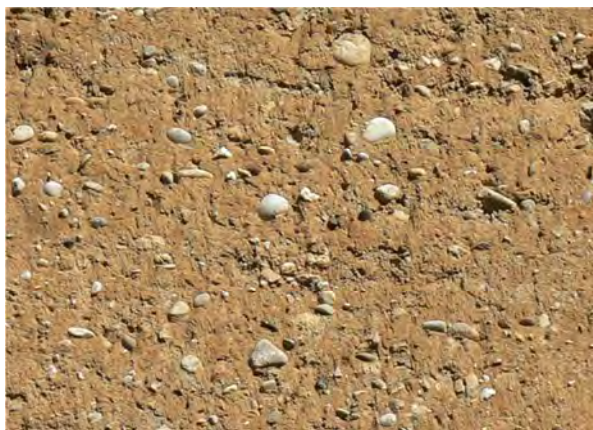
Maçonnerie de pisé de moraines glaciaires (17 rue Royet à Caluire-et-Cuire). Photo E. Mille
