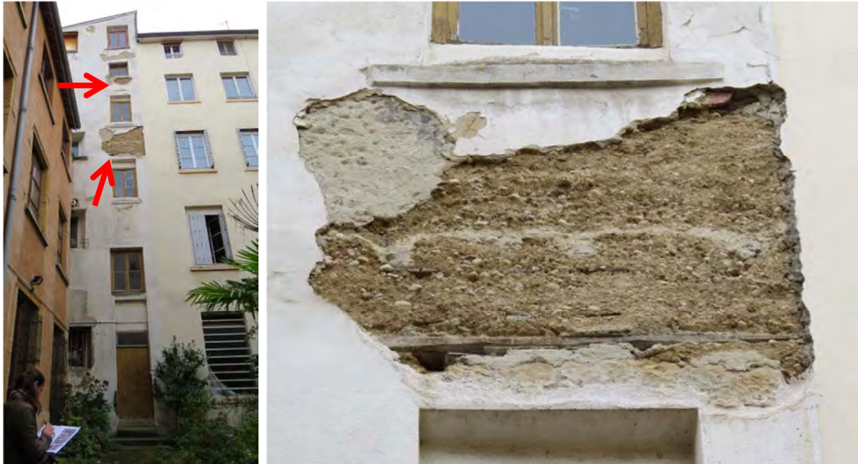
Immeuble de six niveaux rue Raymond, Lyon 1 er (zone UNESCO, ZPPAUP des pentes de la Croix Rousse). La maçonnerie entre les niveaux de baies est en terre. Photographies : Mathilde Aulas.
