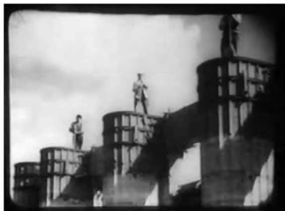
Pisage du mâchefer lors de la construction de l'hôtel de ville de Villeurbanne (Source : Archives de l'Avenir, Ville de Villeurbanne)
