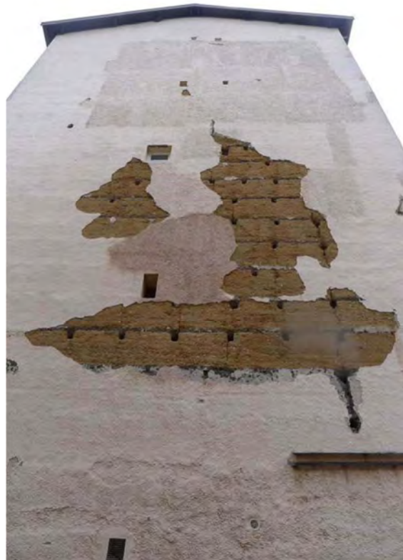
Détail du mur pignon en pisé de l'immeuble situé 43 rue Coste, Caluire-et-Cuire. Photo : A-S. Cléménçon
