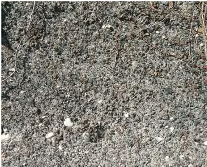
Détail d'une maçonnerie en pisé de mâchefer (Lyon 3e, photographie Emmanuel Mille).
