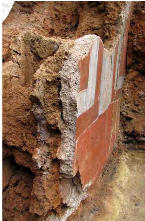
Détail d'une cloison en terre, Lyon, Clos de la Solitude. Source : Clément B. 2016, Fig. 295, p. 414).
