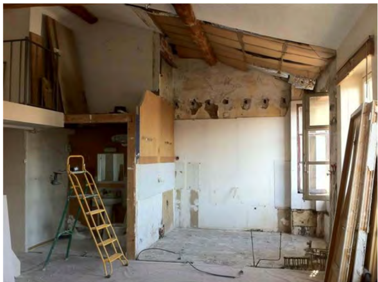
Immeuble situé 12 rue Jacquard, Lyon 4 e . Le pisé de terre est identifié dans le mur mitoyen lors de travaux. Photo : Th de Charentenay
