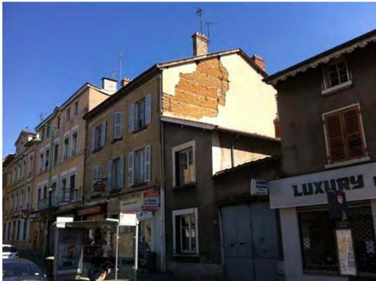
Immeubles en pisé, avenue de la République, Tassin-la-demi-lune. (Image : David Gandreau, CRAterre).
