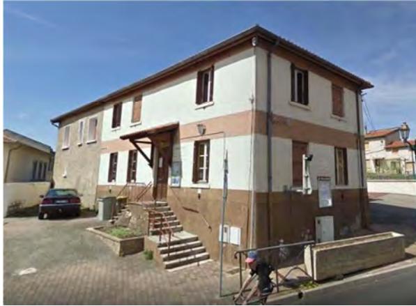
Bâtiment municipal en pisé, Corbas. Récemment restauré, cet édifice a servi de mairie à partir de 1860, puis d'école. Il abrite actuellement des services municipaux et des locaux associatifs. Source : Google street view.
