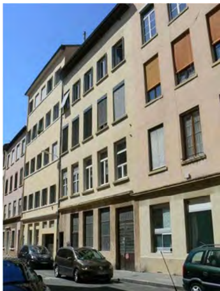
Immeuble situé 12 rue Jacquard, Lyon 4 e . Façade sur rue en pierre. Photo : E. Mille
