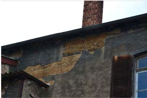
Cinéma Saint-Denis, Grande rue de la Croix-Rousse, Lyon 4 è . Détails de la maçonnerie en pisé de terre. Photographies : E. Mille.
