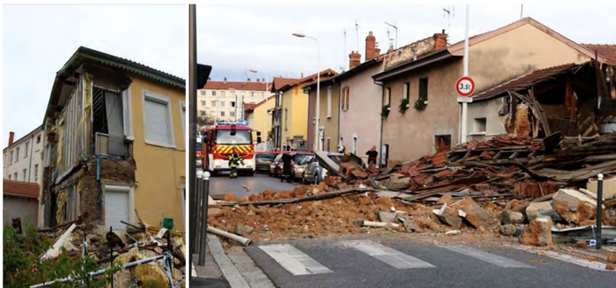
Effondrement d'une maison en pisé en 2016, rue de la Favorite, Lyon 5 e . Photo : Ph. Garnier, CRAterre.
