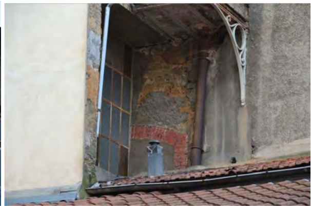
Cinéma Saint-Denis, Grande rue de la Croix-Rousse, Lyon 4 è . Détails de la maçonnerie en pisé de terre. Photographies : E. Mille.
