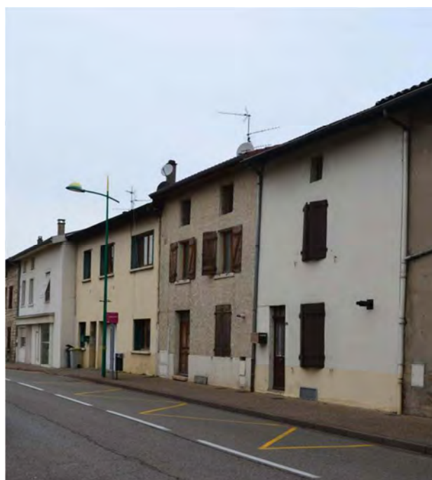
Maisons probablement en pisé du centre-bourg de la Verpillière. Photo : Dora Studer, CRAterre, 2016.
