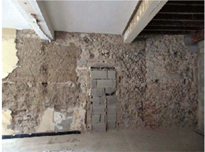
Site de l'Antiquaille : Angle nord-ouest de l'ancienne maison des Buatier (fin du XVIe siècle) et mur en pisé englobés dans le couvent des Visitandines (XVIIe siècle) © Service Archéologique de la Ville de Lyon
