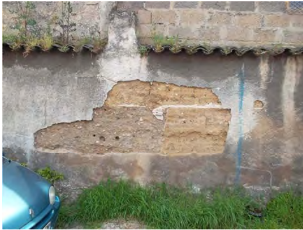
Mur de clôture au fond d'une cour d'immeuble, rue des Tuileries, Lyon 9 e . Photo. : E. Mille.
