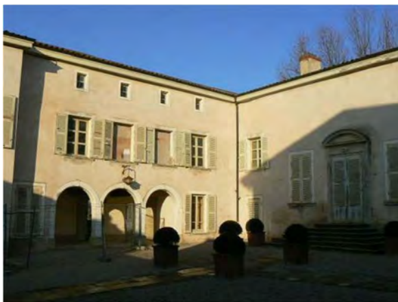
Maison des champs du domaine du Clos de la Haye, dite Maison de Melchior Philibert (XIV e – XVII e siècle), Charly. Certaines maçonneries sont en pisé. Photo : E. Mille.
