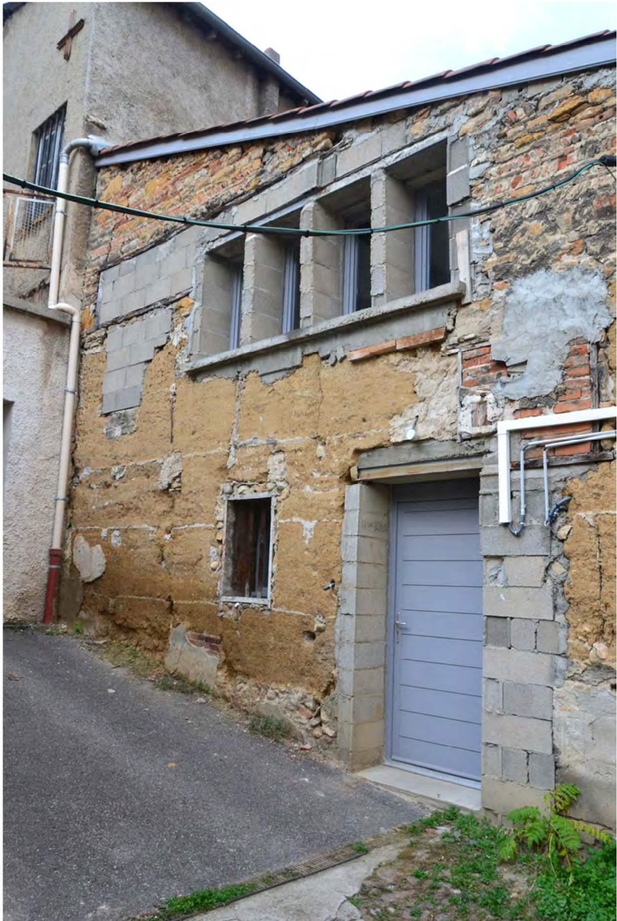
Maison de fond de cour récemment modifiée, 81 Grande rue de la Croix Rousse, Lyon 4 e . Photo : E. Mille 2016
