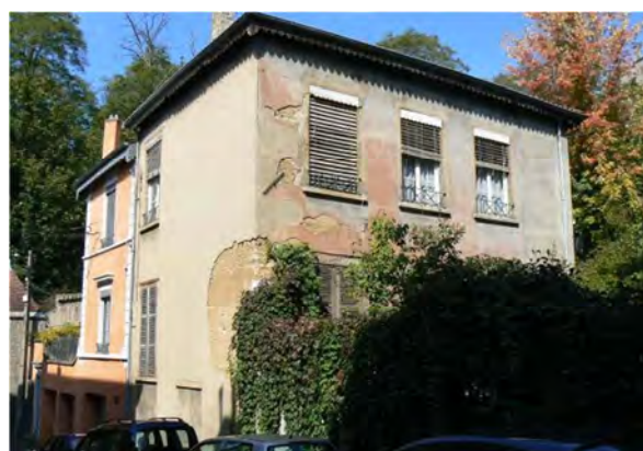
Maison rue Royet, Caluire-et-Cuire. Photo : E. Mille
