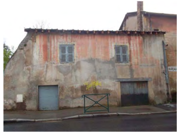
Immeubles en construction à l'emplacement d'anciens bâtiments en pisé de terre. Rue Coste, Caluire-et-Cuire, 2015. Photo : E. Mille Maison en pisé en attente de destruction dans le cadre d'une opération immobilière. Point du Jour, Lyon 5 e . Photo : E. Mille.
