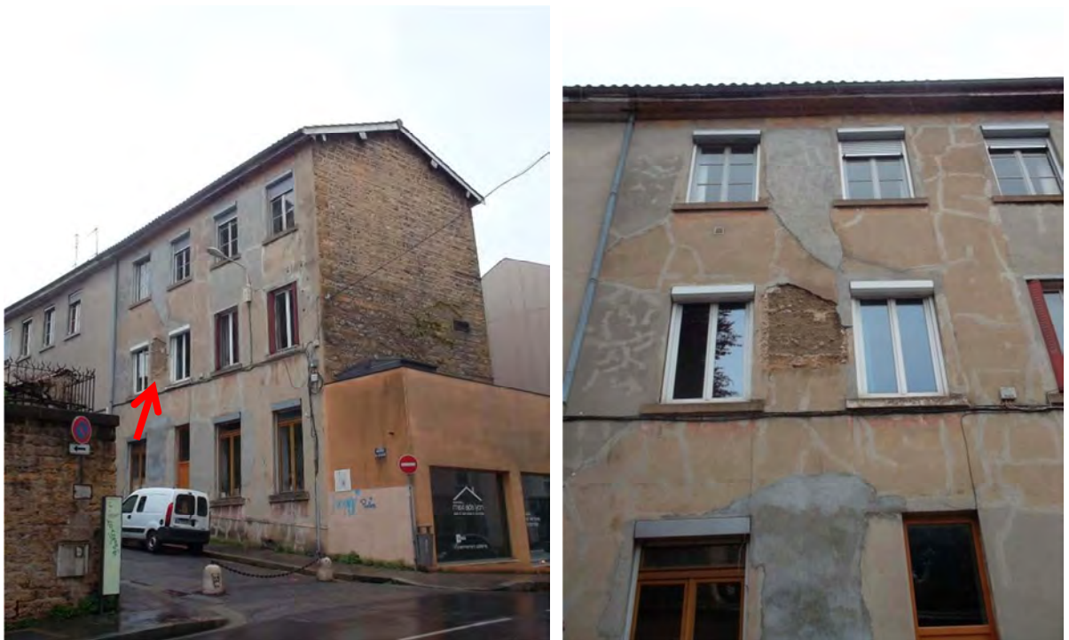
Immeuble de trois niveaux, secteur UNESCO, montée de Loyasse, Lyon 3 e . Vue d'un trumeau en terre. La façade pignon est en revanche en maçonnerie de pierre. Photo. : E. Mille
