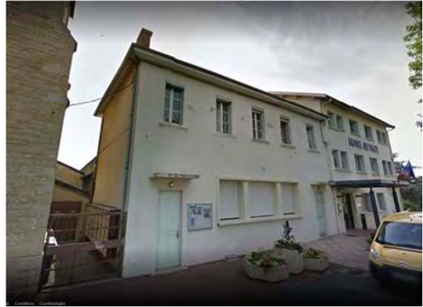
Bâtiment municipal en pisé, Corbas. Cet édifice a servi de mairie à partir de 1891, puis d'école après la construction de la nouvelle mairie au XX e siècle. Source : Google street view.
