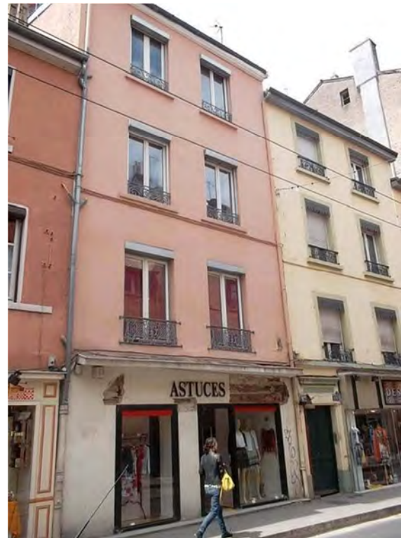
Immeuble de quatre niveaux, Grande Rue de la Croix-Rousse. Le changement d'enseigne laisse paraître du pisé de terre. Les trois niveaux supérieurs sont-ils également en pisé ? Photo : E. Mille
