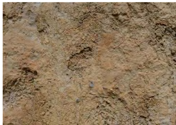
Maçonnerie de pisé de loess (81 Grande rue de la Croix Rousse, à Lyon 4e). Photo E. Mille
