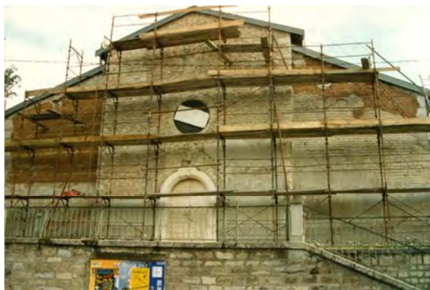
Eglise Saint-Athanase de Cusset, Villeurbanne. Les travaux de 1995 ont révélé des maçonneries de terre en élévation des bas-côtés. Source : Rize, ville de Villeurbanne.
