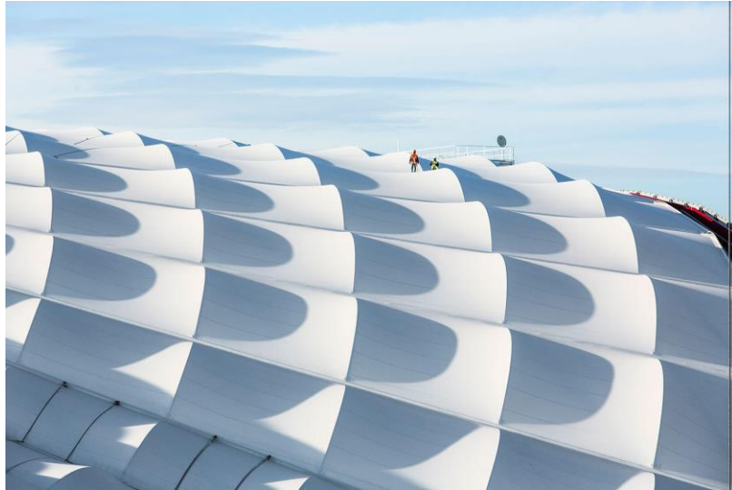
Figure 20 – Toit incurvé du Vélodrome permettant la récupération des eaux de pluies, agence SCAU, mai 2018
