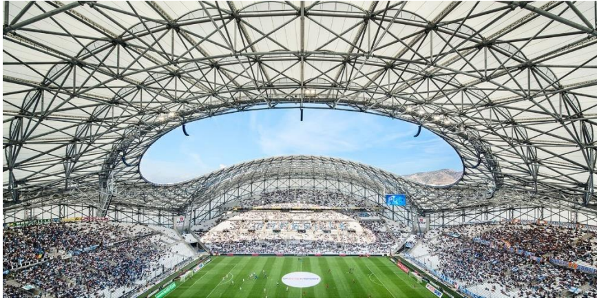
Figure 18 – Nouveau Vélodrome vu du haut de la tribune Ganay, agence SCAU, mai 2018
