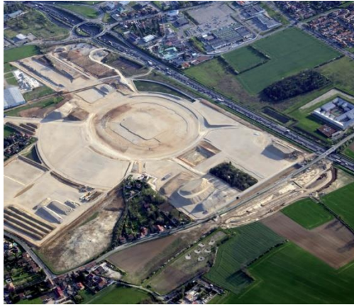
Figure 56 – Réalisation des terrassements généraux du Grand Stade, Vinci Construction France, avril 2013
