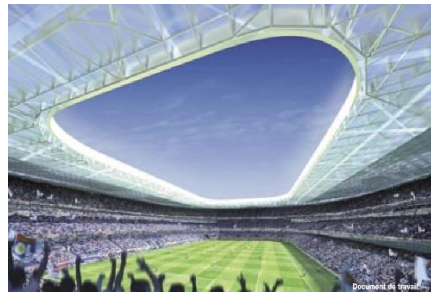
Figure 52 – Image de synthèse présentant la vue intérieure du Grand Stade, avec des tribunes réhaussées et plus raides qu'à Gerland, permettant de rapprocher le spectateur du terrain, OL Groupe, novembre 2007
