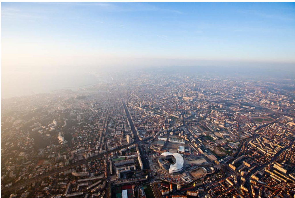
Figure 26 – Stade Vélodrome en travaux en 2014, vue aérienne, agence SCAU, mai 2018
