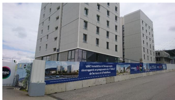
Figure 115 – Deux immeubles de bureaux en construction au nord du stade, Romain Bruno, mai 2018
