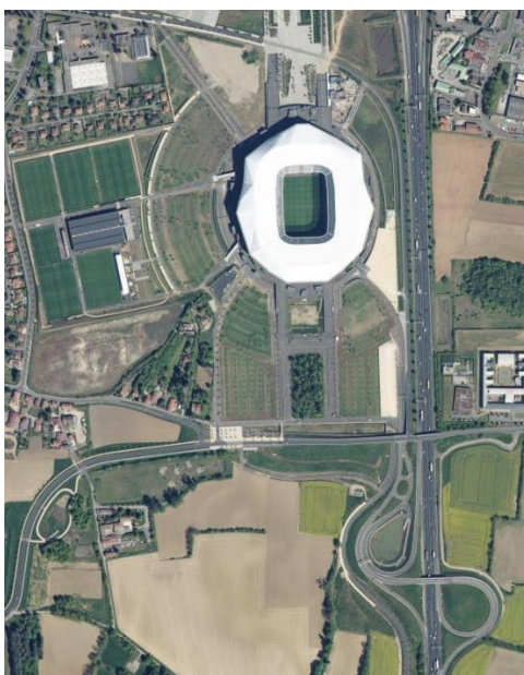
Figure 103 – Au Sud Est du complexe, l'échangeur 7 de la rocade qui dessert le stade, 'Photographies aériennes' Géoportail, août 2018
