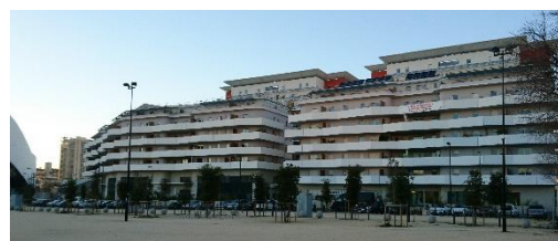
Figure 81 – Deux des bâtiments résidentiels et de bureaux vus depuis l'esplanade Ganay, janvier 2017
