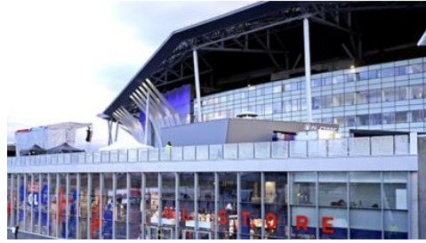
Figure 118 - Rez-de-chaussée de l'OL Store, Groupama Stadium, août 2018
