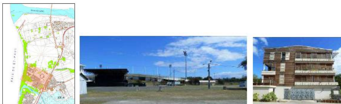
Figure 24 : Environnement au Sud du site : Une opération immobilière récente et un pôle de sports et de loisirs
