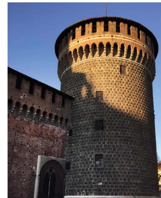
Figure 20 : Vue depuis un passage menant à la place d'armes et donnant sur la tour des Carmines en 2013.
