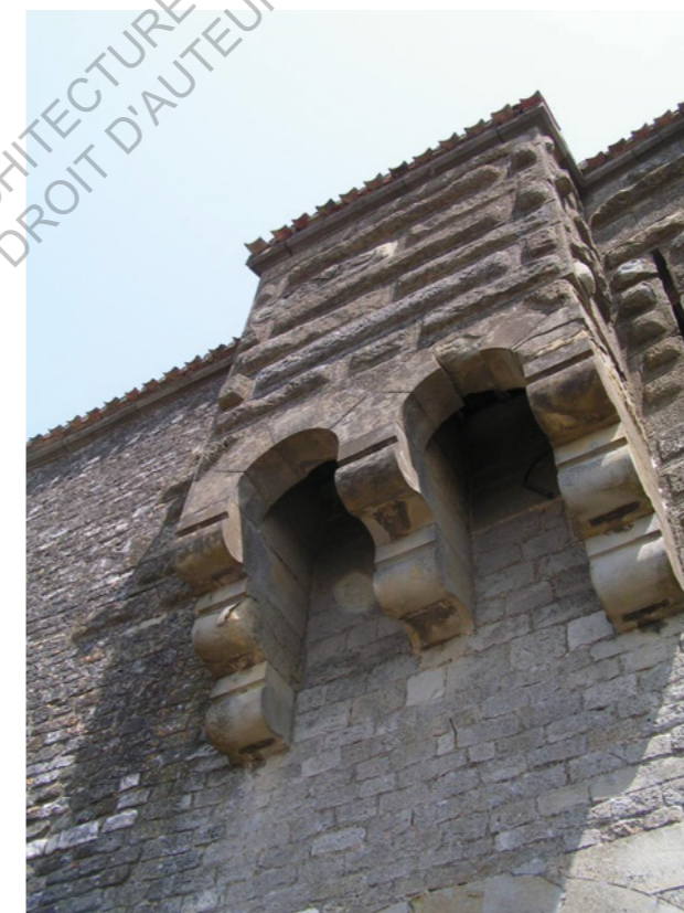
Figure 30 : Vue sur les mâchicoulis du château Comtal à Carcassonne en 2011.
