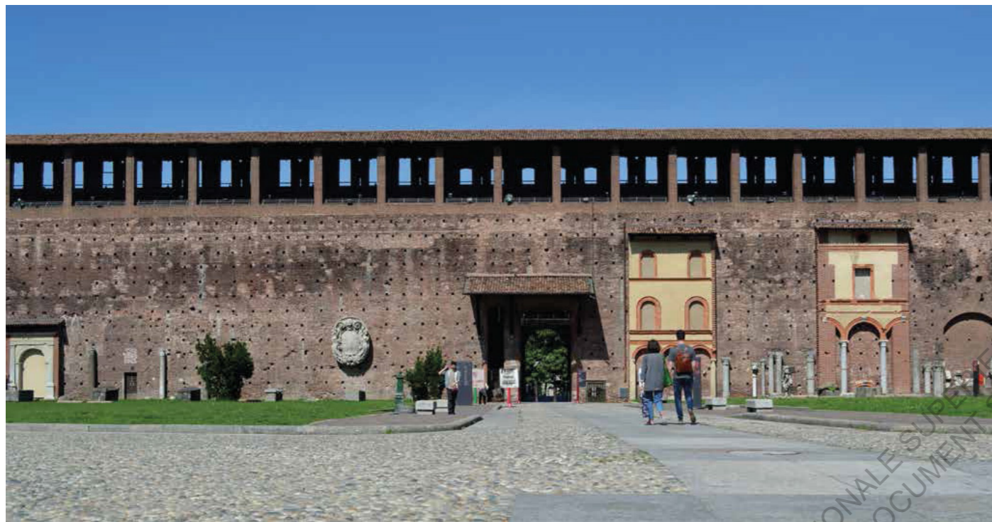
Figure 26 : Vue depuis la place d'armes de la façade des Carmines principalement composée de remparts et comportant des greffes d'édifices extérieurs au château en 2016, photo personnelle.
