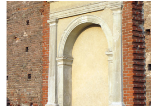
Figure 35 : Vue sur une greffe de la façade des Carmines présentant un assemblage d'une architecture extérieure au château en 2013.
