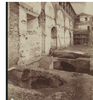
Figure 66 : Archive photographique présentant l'excavation des sols afin de permettre la mise en place du métro milanais entraînant la destruction d'une partie du passage souterrain de la Ghirlanda.
