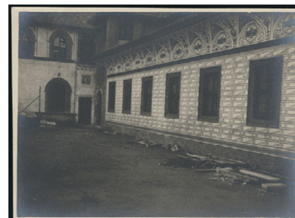
Figure 76 : Archive présentant le début des travaux de Beltrami consistants en la destruction du premier étage de l'ancien hôpital espagnol en 1893.
