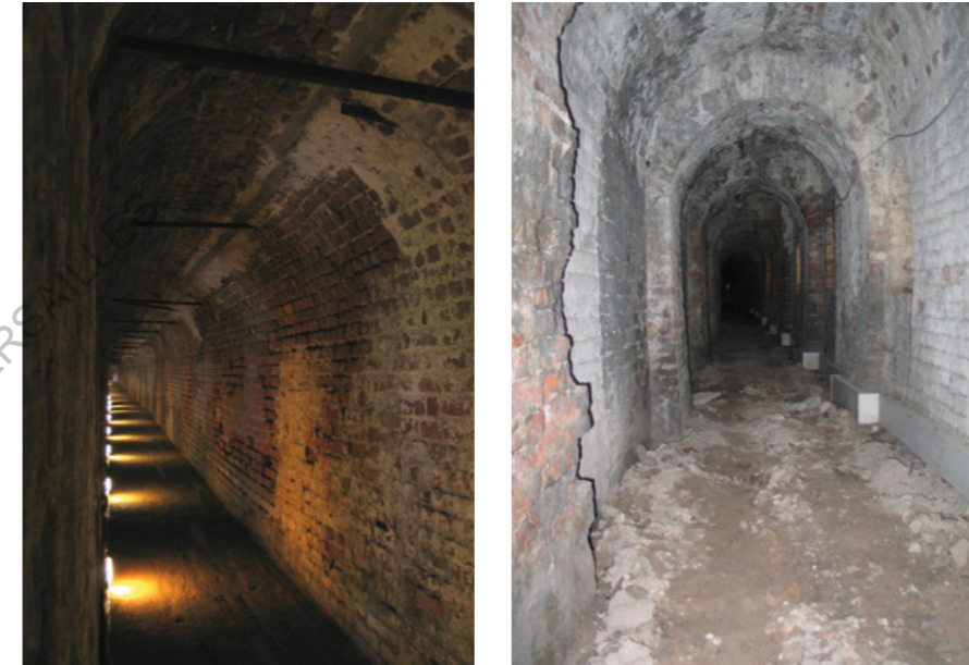
Figure 86 : Ensemble de deux photos présentant l'évolution d'une partie du chemin couvert de la Ghirlanda avant et après la restauration de la fin du XXe siècle.
