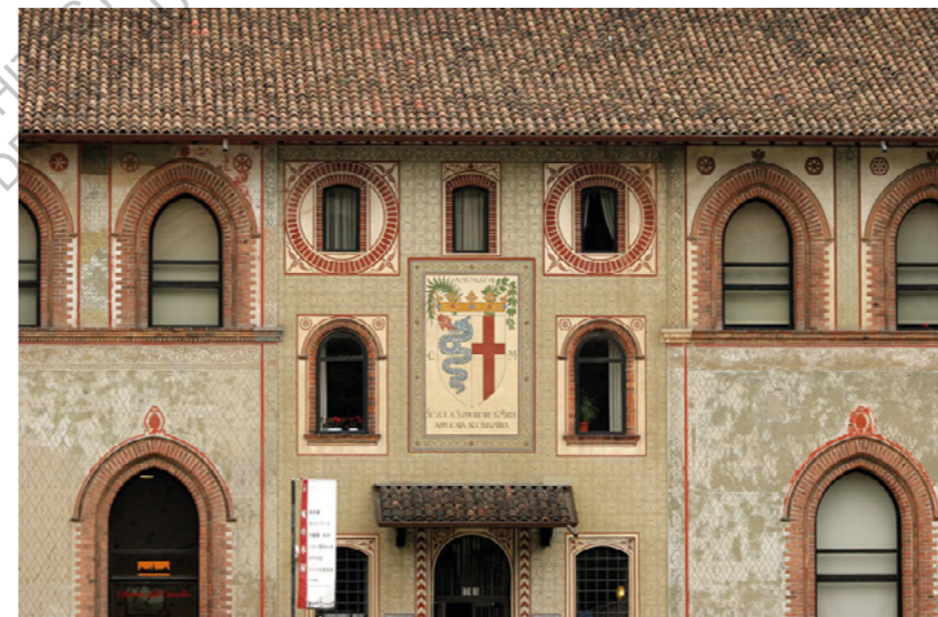
Figure 23 : Partie représentant une discontinuité au niveau de l'organisation géométrique de la façade regroupant l'actuelle bibliothèque et l'école d'art en 2011.
