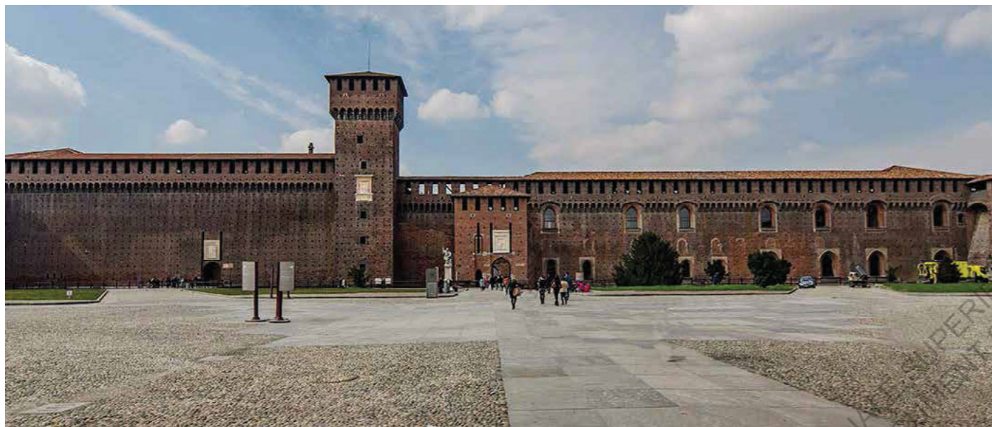
Figure 25 : Vue depuis la place d'armes de la façade qui donne sur la Rochetta et composée de la tour de Bona, la porte Giovia et des remparts en 2013.
