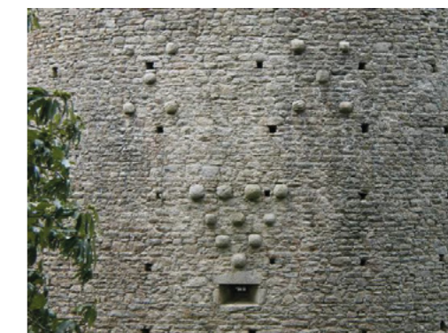
Figure 31 : Vue sur les trous de boulins issus du château de Ranrouët en 2013 et situé dans la commune de Herbignac.
