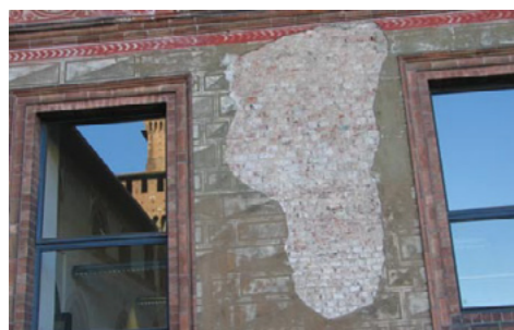
Figure 87 : Archive photographique montrant la dégradation de la façade de l'ancien hôpital espagnol, un siècle après la restauration de Beltrami, en 2003.
