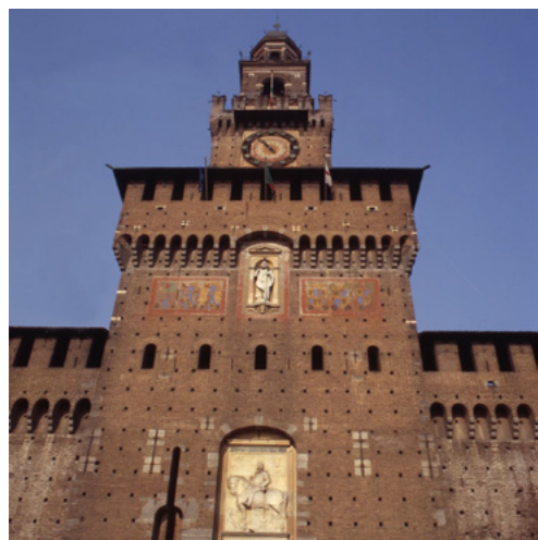
Figure 12 : Vue en contre plongée de la tour de Filarete en 2016, photo personnelle.
