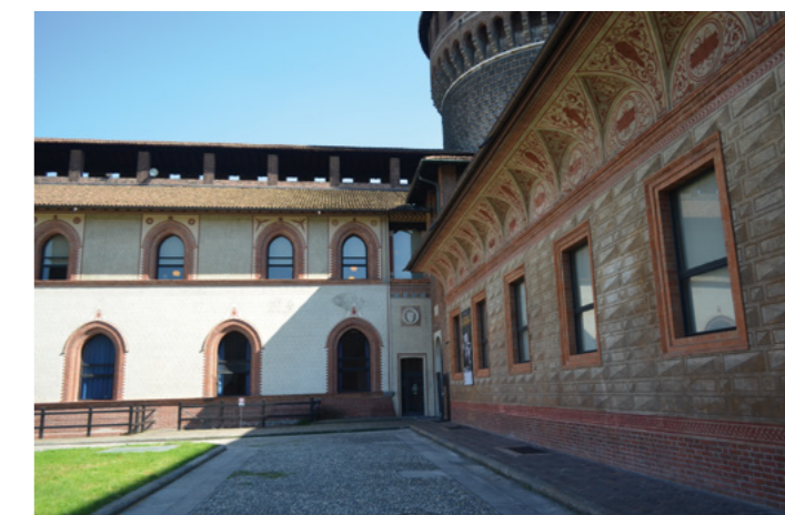
Figure 58 : Vue depuis la place d'armes sur l'ancien hôpital espagnol en 2016, photo personnelle.
