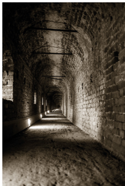
Figure 8 : Le passage souterrain couvert de la Ghirlanda en 2016.
