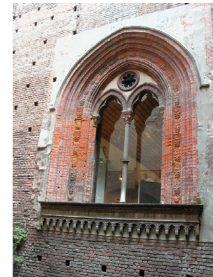
Figure 45 : Fenêtre à une baie avec un ensemble décoratif réalisé en terre cuite et composé d'un poteau en pierre en 2015.
