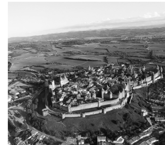
Figure 7 : Vue aérienne de la cité de Carcassonne réalisée en 2016.
