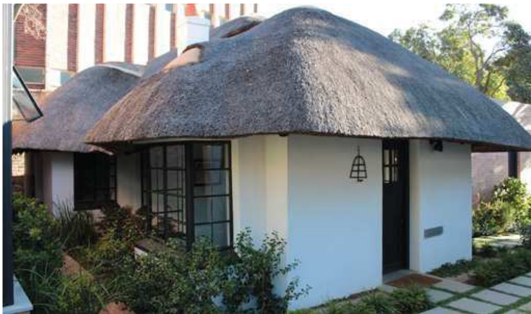
Photographie 19 : L'extérieur du cottage Kallenbach
