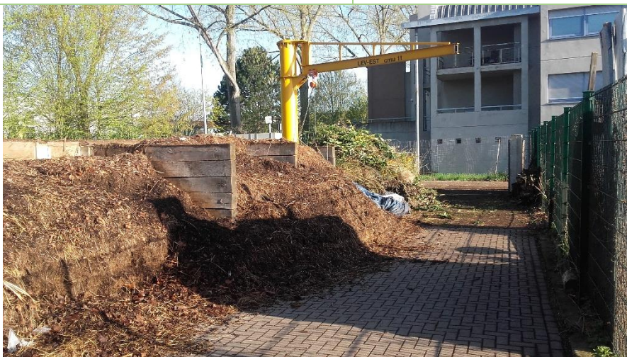
Image 6 Box de stockage à l'entrée de la plateforme. Notez que les volumes débordent des limites prévues
