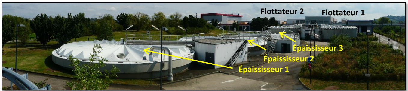
Figure 11 – L'UF5 de la station de Pierre Bénite (Épaisseurs et Flottateurs)
