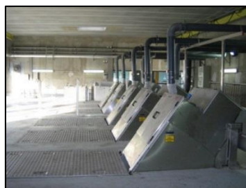
Figure 7 – Photo des tamiseurs de la station de Pierre Bénite (source : GRAND LYON)
