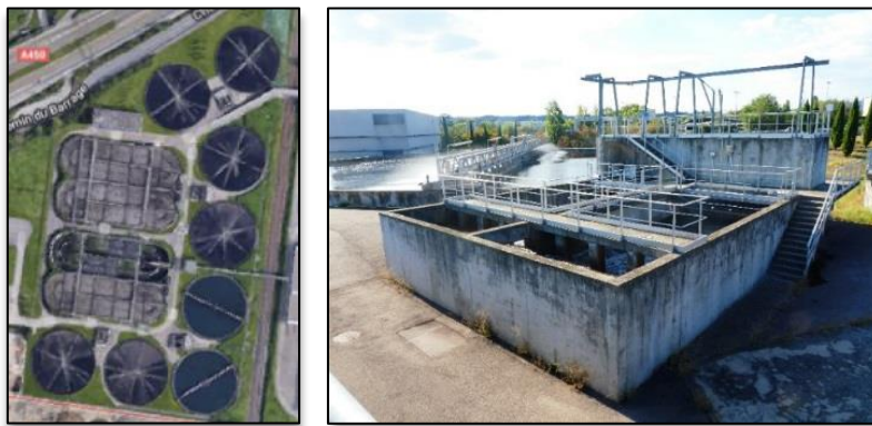
Figure 10 – A gauche : vue aérienne de l'UF4 – A droite : Un dégazeur/puits à boue
