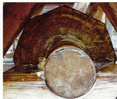
L'arbre du mécanisme a été équarri à la doiloire dans un fût de chêne (31) (32) (33) jusqu'à obtention d'un axe hexagonal (34). L'assemblage du mécanisme a commencé par la pose de l'arbre qui assurera la rotation du rouet. L'arbre se termine par un tournillon posé sur un coussinet en chêne (35).
