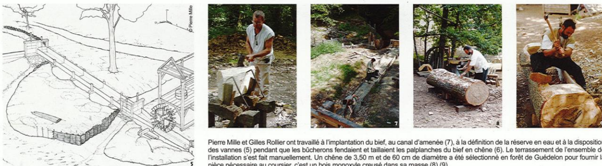
La construction du moulin hydraulique à farine de Guédelon s'est échelonné sur les saisons 2012 et 2013, en complément du chantier de construction du château. Les bûcherons ont équarré les pièces de bois et fendu les tavaillons de la couverture. Les charpentiers ont tracé, taillé, assemblé (1) (2) et levé la charpente du moulin (4). L'arbre du mécanisme et l'ensemble des pièces ont été transportés par nos chevaux (3).
