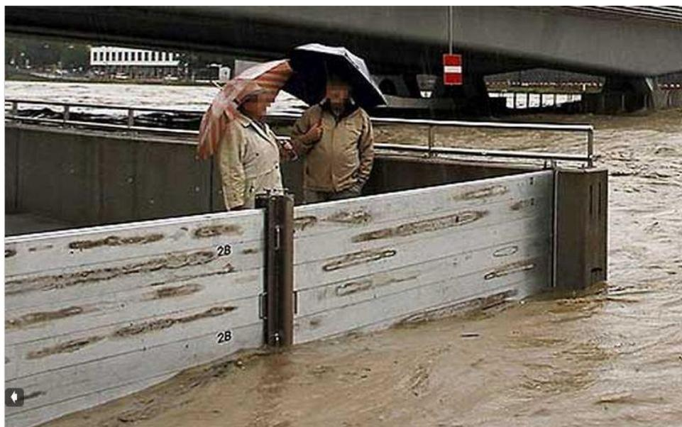
Figure 31 : Exemple de fonctionnement de Batardeau (source MSEI)
