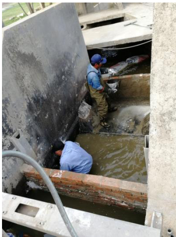
Photo 4 : Curage de la fosse d'arrivée (GITEC, 2018)
