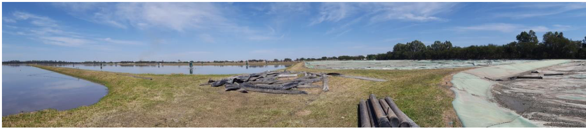
Photo 3 : Aperçu d'une partie des lagunes anaérobies couvertes et lagunes facultatives (GITEC, 2018)
