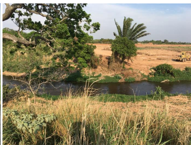
Photo 2 : Futur point de décharge dans la rivière au niveau de la STEU Motacusal (GITEC, 2018)
