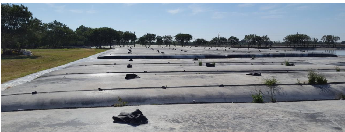
Photo 7 : Géotubes® installés à la STEU Este (GITEC, 2018)
