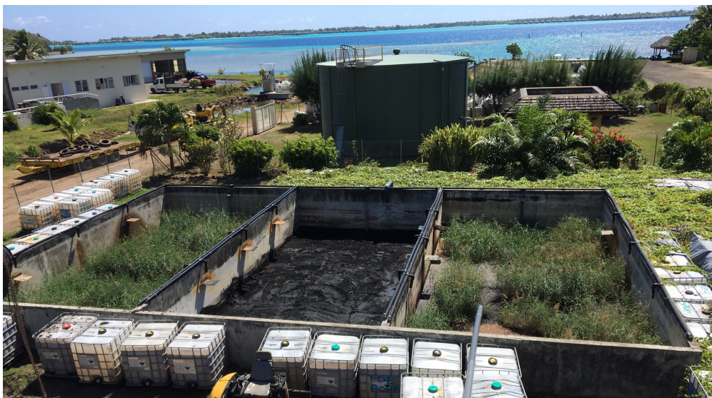
Photo 5: Aperçu des trois lits plantés de roseaux de la station de traitement des graisses de BoraBora. Le lit du centre a été vidé.
