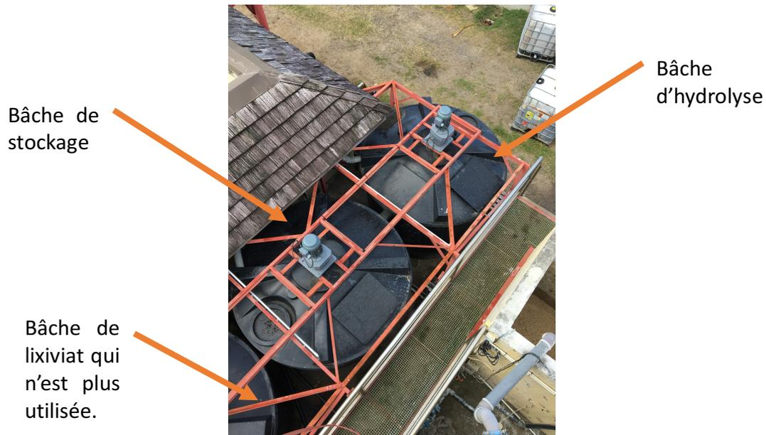
Photo 3: La cuve de gauche est la bâche de stockage et la cuve de droite est la bâche d'hydrolyse
