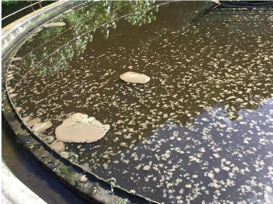
**Photo 9: Boue en surface du clarificateur de la station de traitement des eaux usées de Faanui**
