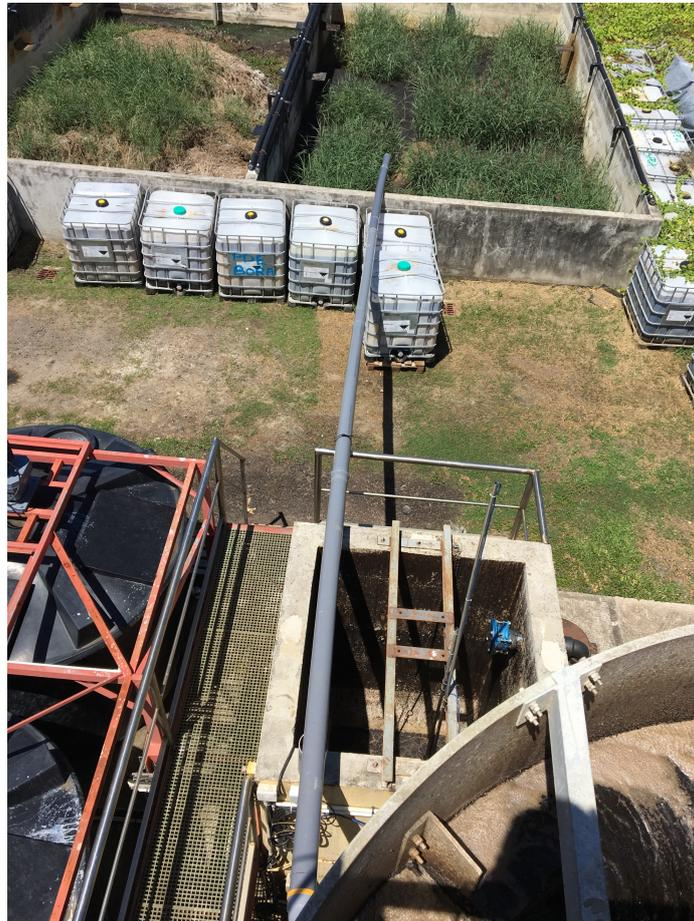
Photo 10: Clarificateur bypassé par la conduite PVC qui débouche directement sur le lit planté de roseaux 3
