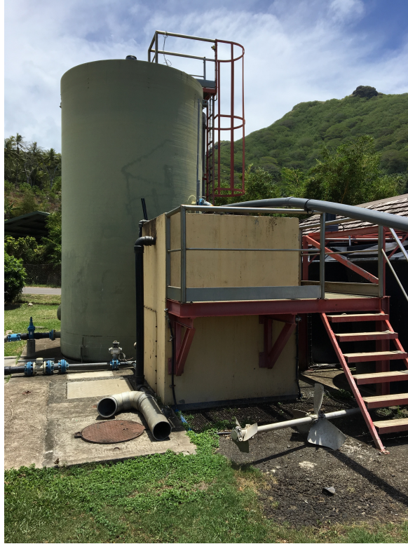
Photo 4: Réacteur Carbofil de Bora Bora
