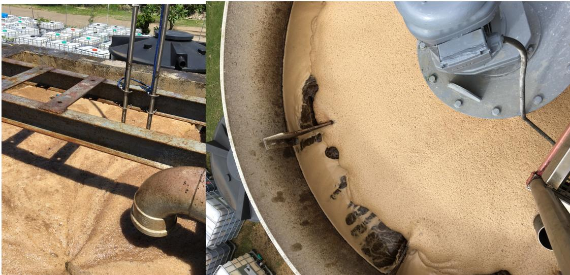
Photo 1: Moussage au niveau de l'épaississeur des boues (photo de gauche) et du réacteur Carbofil (photo de droite)
