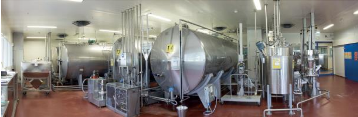
Figure 29 : Zone de fabrication du rez de chaussée
