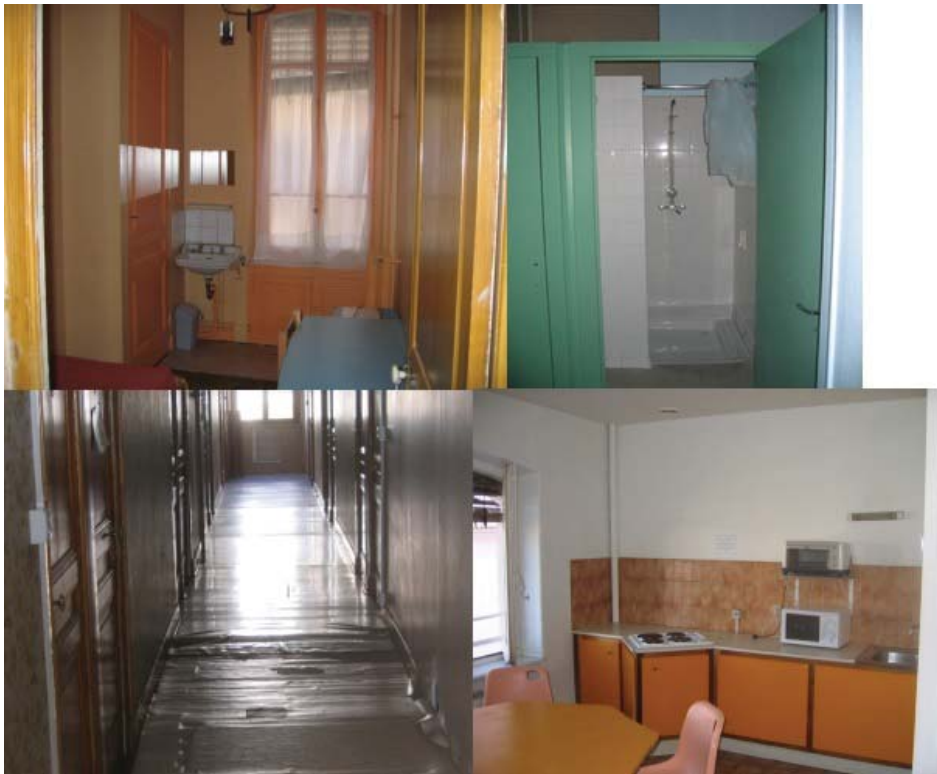
Figure 42 : Avant la réhabilitation. © Escale Lyonnaise, 2007.
