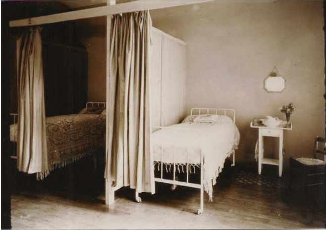
Figure 41 : Les dortoirs à l'époque des sœurs. Photo datant de 1973. © Escale Lyonnaise
