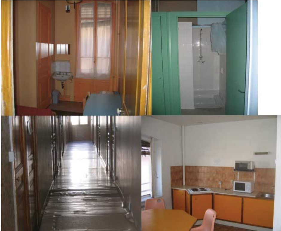
Figure 42 : Avant la réhabilitation. © Escale Lyonnaise, 2007.
