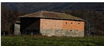
Photos : Exemples de constructions de murs de pierre où la pierre a été remplacée par la brique à Calvelo. 2013. Source: AFP
