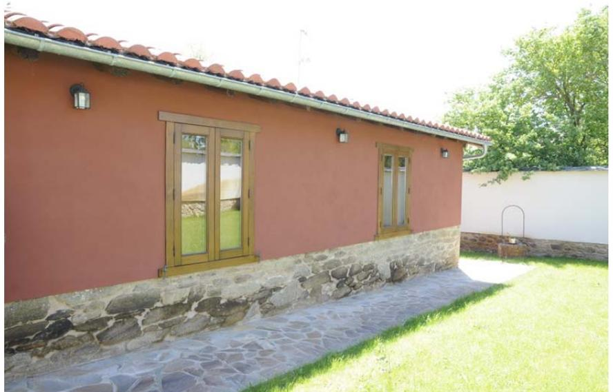
Photo : Exemple de réhabilitation avec enduits en ciment des murs en pisé du Pazo Muíños de Antero. Source: AFP
