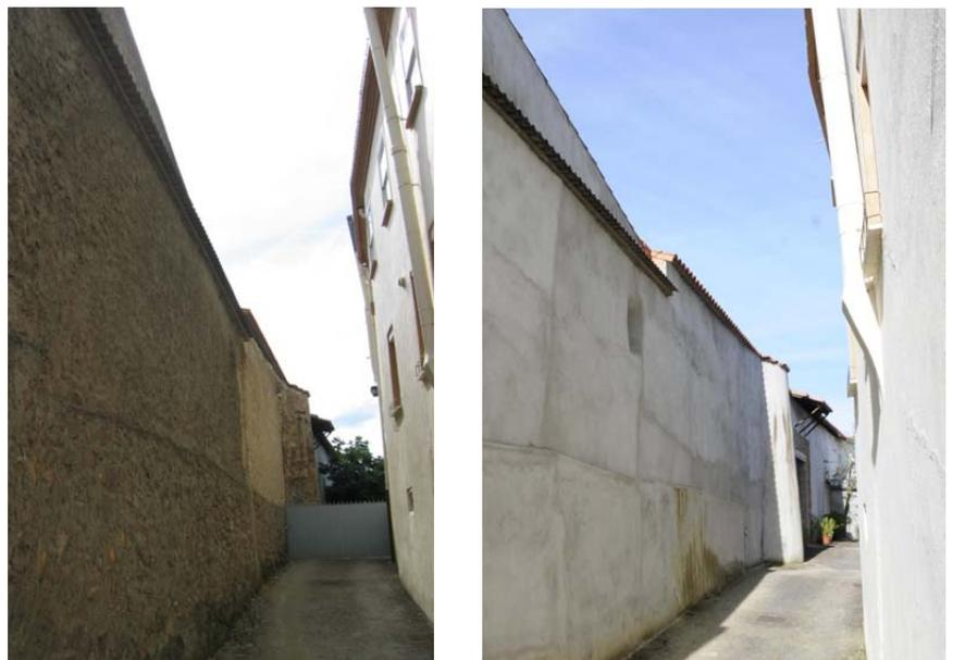
Photo: Mur original du Mosteiro das Clarisas à gauche (2011) et enduit en ciment réalisée quelques années après à droite (2014). Source: AFP
