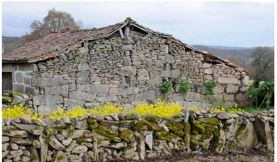
Photo. Mur où les *terróns* ont été substitués par des pièces de granit non taillé au village de Penouzos. 2013. Source : AFP.
