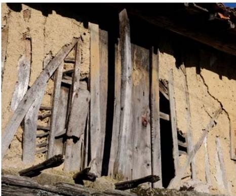
Photo: Détail de la cloison extérieure en torchis dans la façade protégée de la pluie à Vixueses 2013 : Source : AFP
