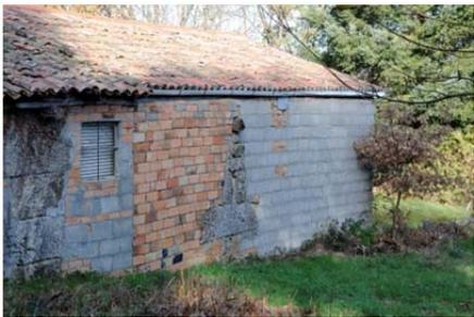
Photo : Bâtiment auxiliaire à Cancillós, dans lequel on conserve encore la structure granitique des constructions avec *terróns*. 2013. Source : AFP.
