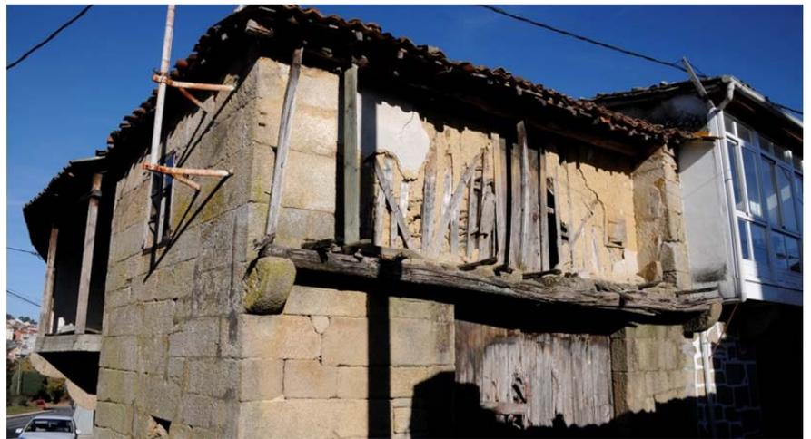
Photo: Bâtiment avec cloison extérieure en torchis dans la façade protégée de la pluie à Vixueses 2013 : Source : AFP
