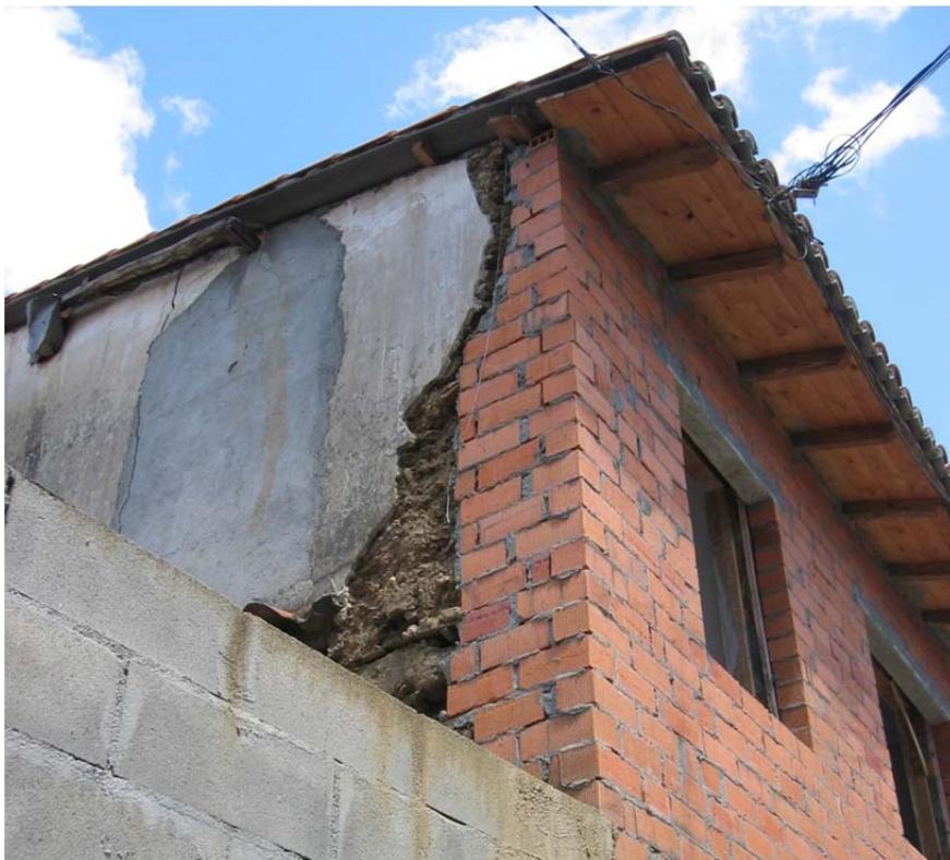
Photo. Nouvelle façade en brique cachant le mur en pisé. Monforte de Lemos. 2009. Source: AFP
