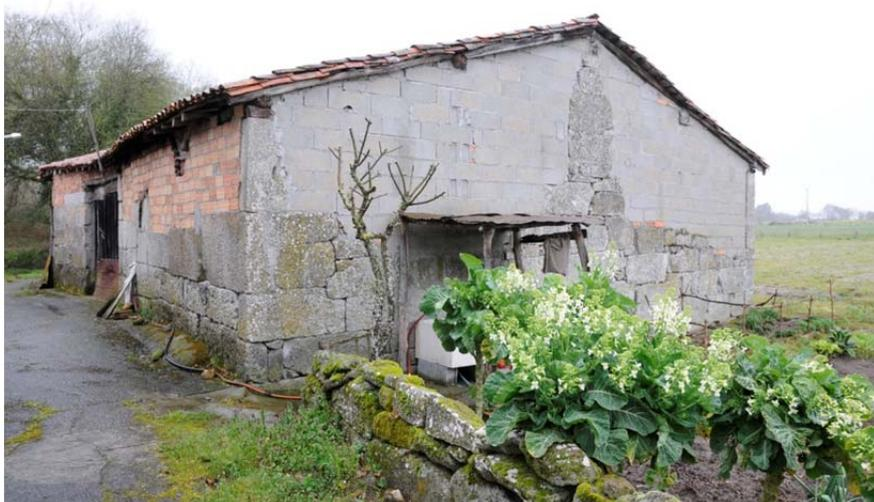
Photos : Murs où les *terróns* ont été substitués par des briques en béton au village de Trabazos. 2013. Source : AFP.
