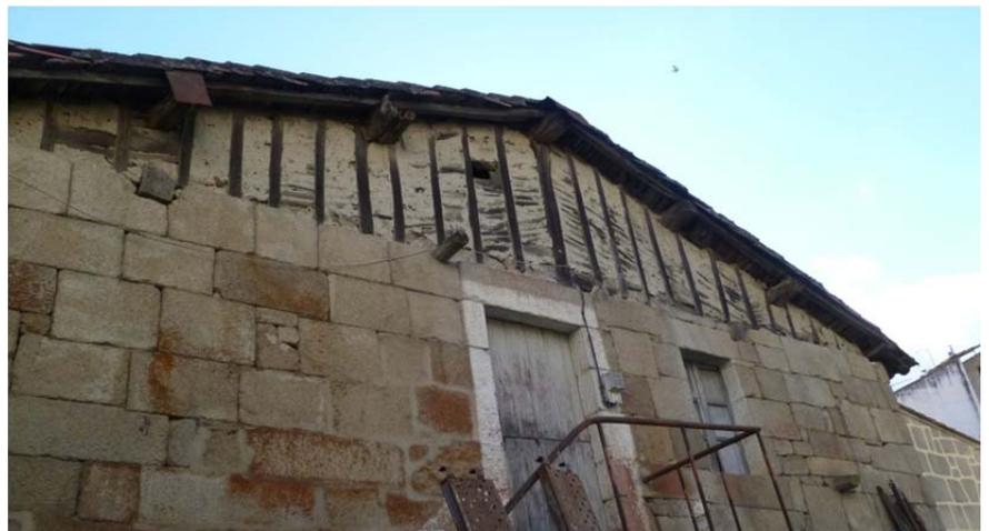
Photo: Batiment de la vieille ville de Verín qui n'a pas agi sur le mur de pallabarro. 2015. Source: AFP.
