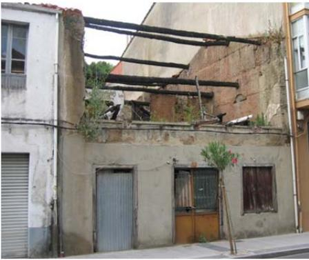
Photo: Constructions en pisé à Monforte montrant la structure de murs mitoyens. 2011. Source: AFP
