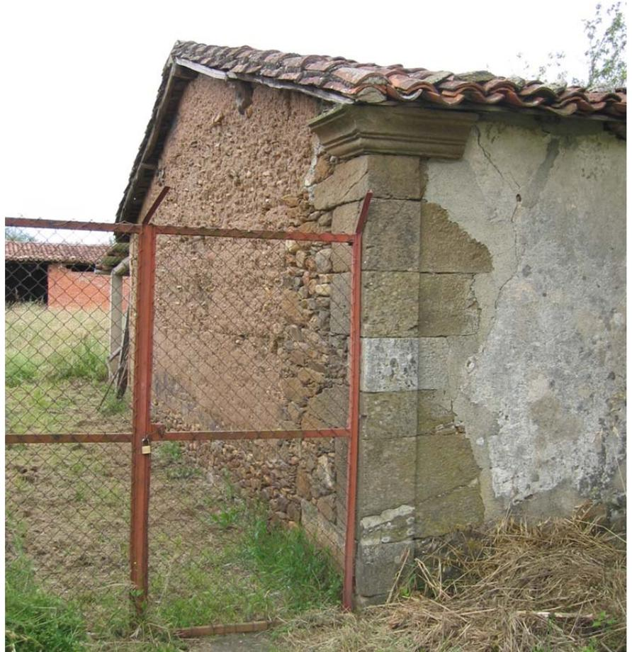
Photo: Construction auxiliaire en pisé avec façade en pierres taillées. 2010. Source: AFP
