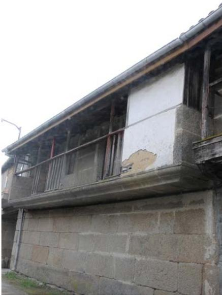
Photo: Cloison extérieur en torchis de la galerie à Cortegada. 2012. Source : AFP
