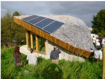
Photos: Le Biovalvo. Bâtiment expérimental avec enduits en terre avec coquilles de moules.
