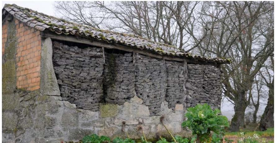
Photos. Construction type "en granit" avec piliers de granite. Lavandeira. 2013. Source : AFP.
