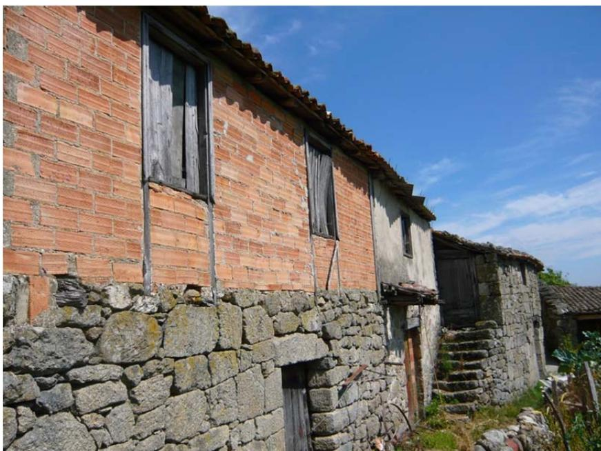
Photo. Substitution du mur en torchis par un mur en briques. San Lorenzo. Parade de Sil. 2015. Source: AFP
