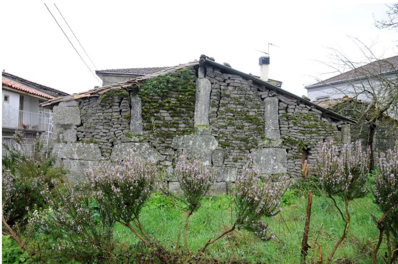
Photos. Constructions type "en granit" avec piliers et une partie du mur en granite. Lavandeira. 2013. Source: AFP.
