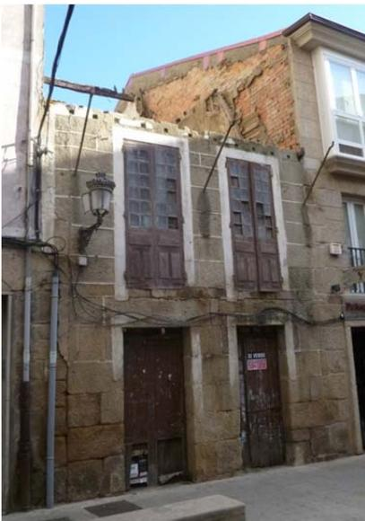
Photo: Maison à ossature bois avec façade en pierre cachant sa structure. 2012 Source : AFP.
