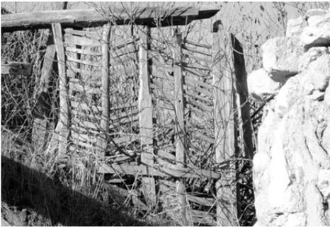
Image: Détail de la structure d'un *tabique de pallabarro*. 2013 Source : AFP.
