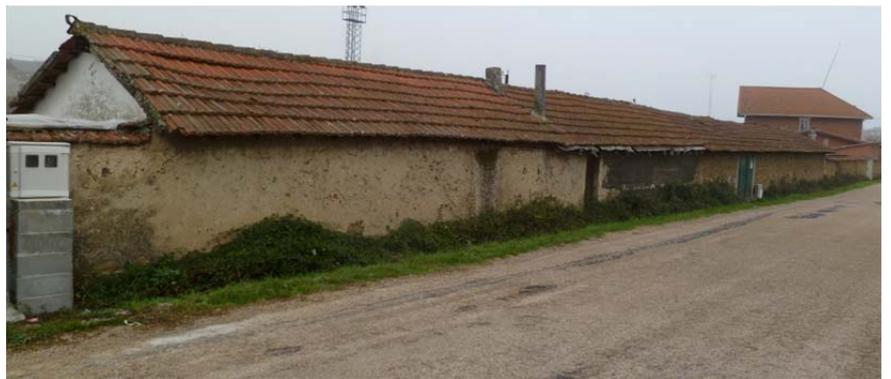
Photo: *Casa del Sobrestante*. Construction en pisé qui servait de local technique pour les installations ferroviaires. 2011. Source: AFP.
