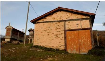
Photo : Bâtiment auxiliaire dans le village de Parada construit avec la logique traditionnelle avec du bois et de la brique 2013. Source: AFP
