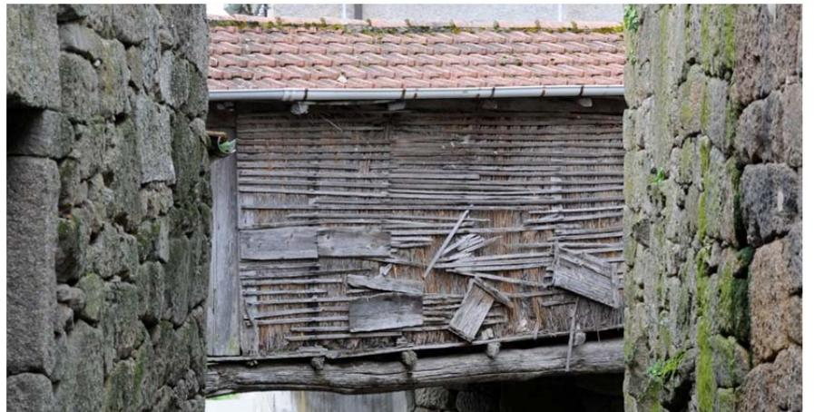
Photo : Bâtiment avec cloison extérieure en *barrotiño* à Cortegada. 2012. Source : AFP
