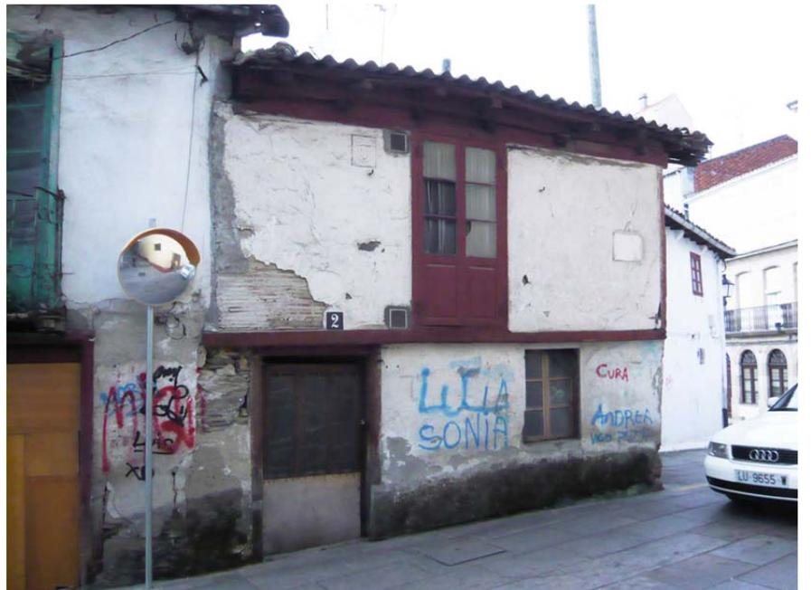
Photo : Bâtiment avec cloison extérieure en *barrotiño* à Monforte de Lemos. 2010. Source : AFP
