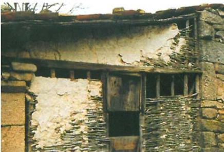
Photo : Cloison extérieure en torchis : Source : Caamaño, M, 2003.
