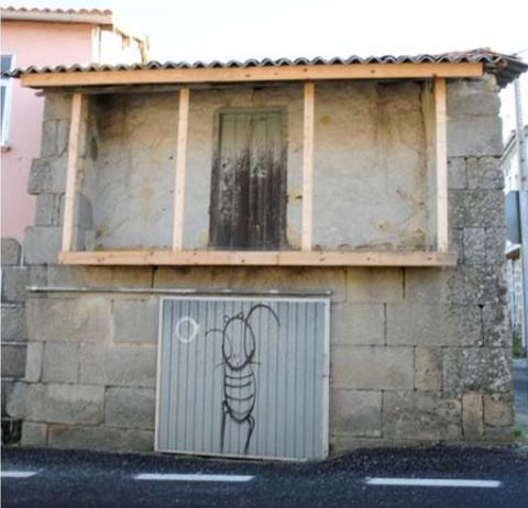
Photos : Constructions auxiliaires à Vixuseses, avec cloisonnage en torchis. 2013. Source: AFP
