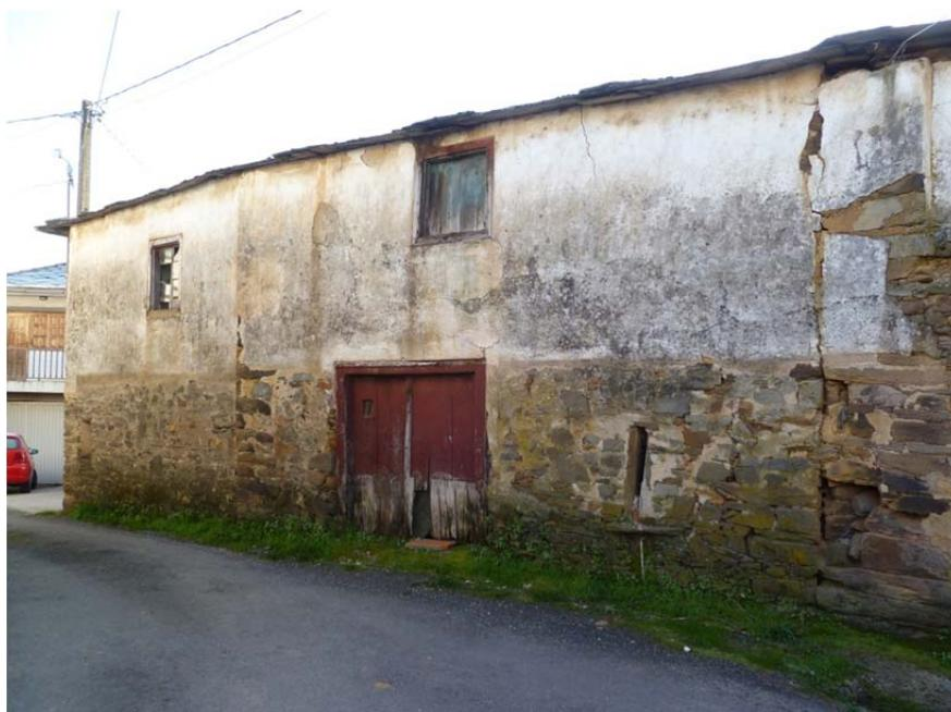
Photo: bâtiment en pisé avec soubassement en pierre au rez-de-chaussée á Bóveda. 2011.
