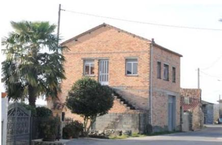
Photo : Bâtiment à Xunqueira de Espadañedo où la brique est utilisée avec des critères inadéquats en utilisant une brique normale comme parement. 2013. Source: AFP
