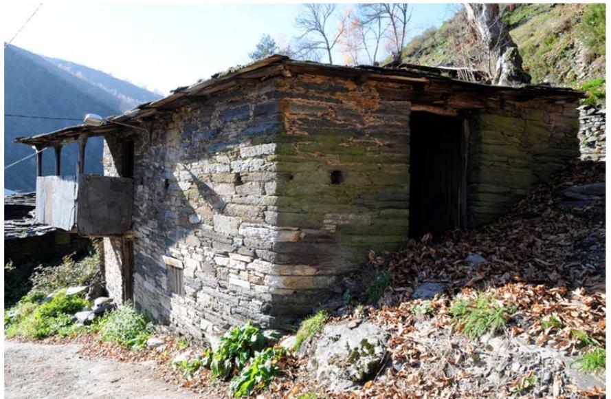
Maison dit d'A Rodeira à Vieiros, Quiroga, 2016. Construction bâtie en pierre de schiste. Le rez-de-chaussée, l'ancienne étable, n'a pas de mortier, est un mur en pierre sèche. Cependant, le mur en pierre à l'étage, l'habitation, était fait avec du mortier en terre. Ça veut dire que le mortier était utilisé comme protection et amélioration de l'ambiance et pas nécessairement pour la construction du mur. Source : AFP.
