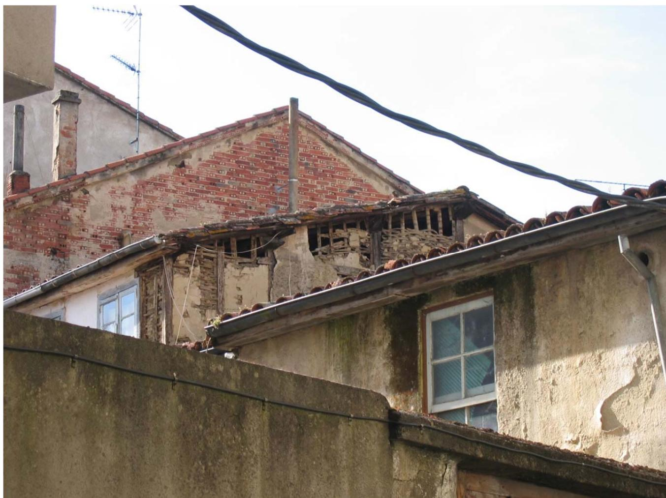
Photo: Détail d'un ancien mur en torchis *cesteadó* à Monforte de Lemos. 2010. Source: AFP.
