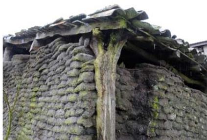
Photo: Détail du pilier en «Y» qui supporte la toiture. 2013. Source : AFP.
