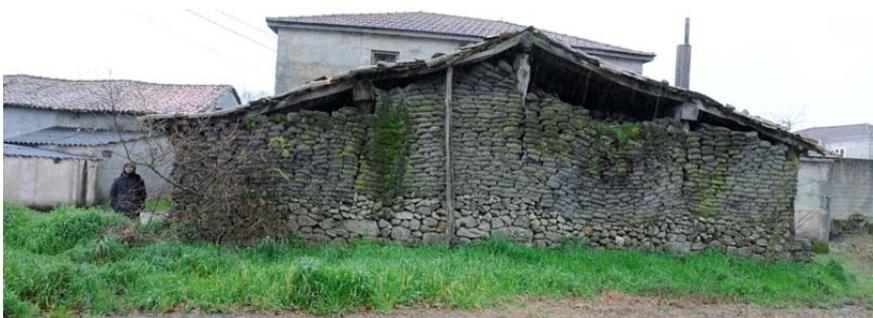
3 Photos: Structures type « en bois » avec mur de *terróns* et soubassement en granit avec piliers en bois. 2013. Source : AFP
