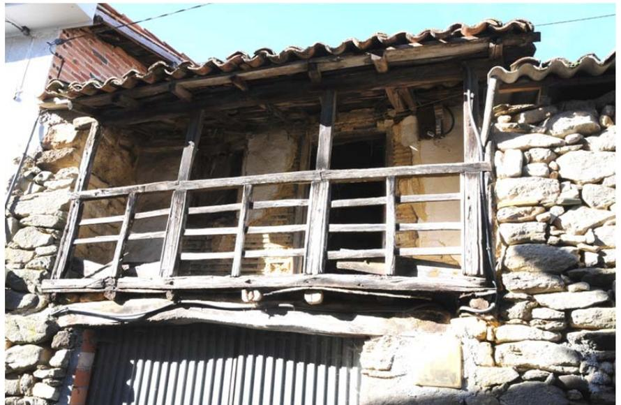
Photo : Constructions auxiliaires avec cloisonnage en torchis. 2013. Source: AFP
