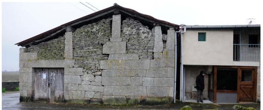
Photos. Construction type "en granit" avec piliers et une partie du mur en granit. Lavandeira. 2013. Source: AFP.
