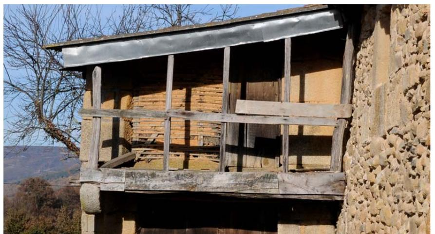
Photo : Bâtiment avec cloison extérieure en *tabique de pallabarro* à Barxela. 2013. Source : AFP.
