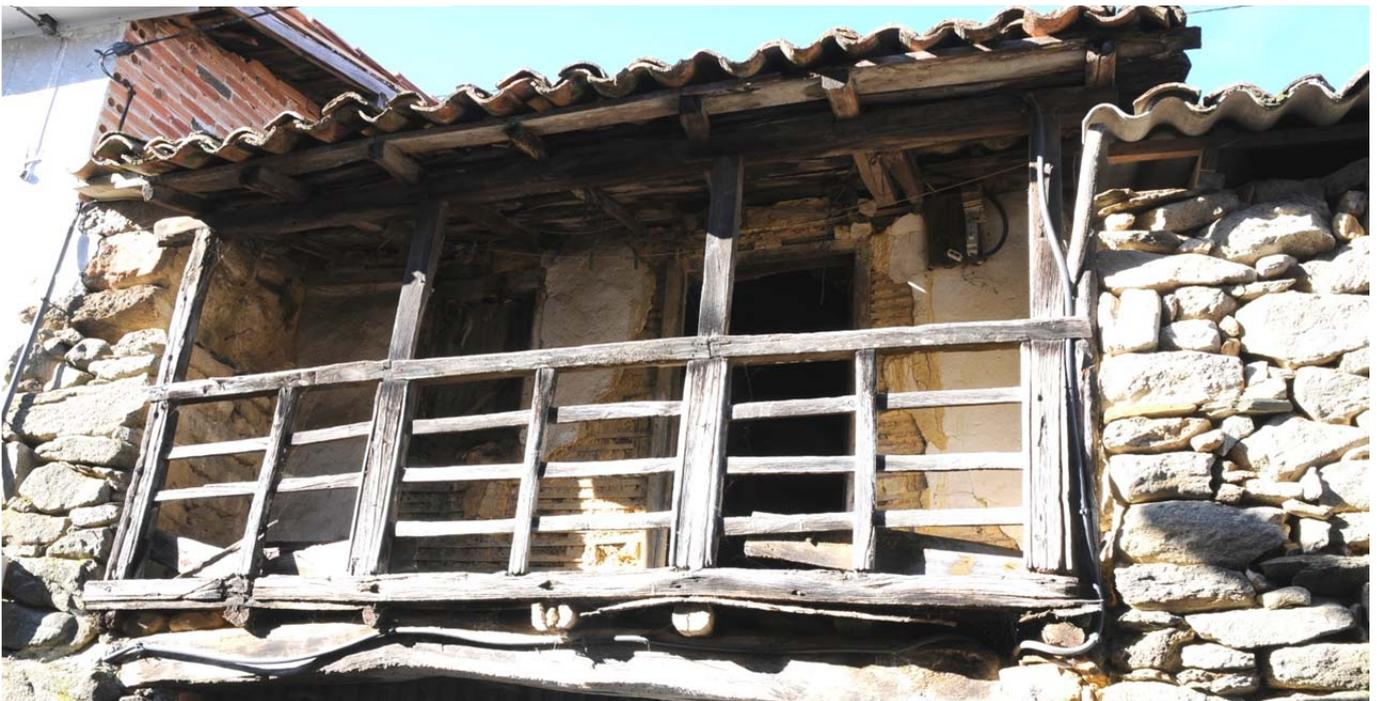
Photo: Cloison extérieure en torchis dans la façade protégé de la pluie à Cimadevila, Maceda. 2013. Source : AFP
