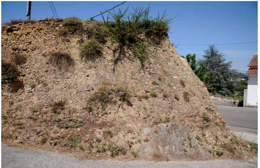
Photo: Exemple de mur en bauge à Goian. 2016. Source : AFP
