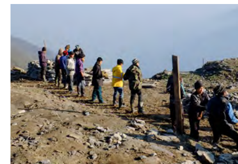
Stockage de pierres durant une phase de préparation d'un chantier sur le site de Khopra.
