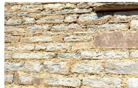
Terre utilisée comme mortier dans un mur de maçonnerie en pierre.
