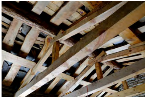
Détails d'une charpente en bois.
