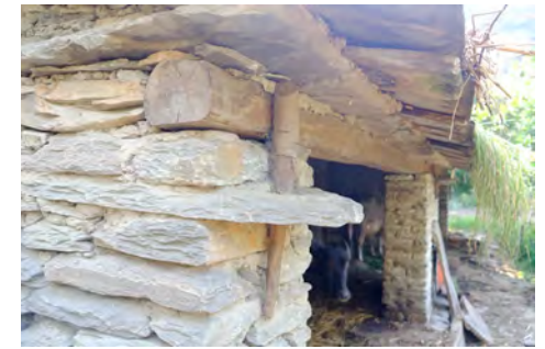
Assemblage chevillé pierre / bois retenant un linteau.
