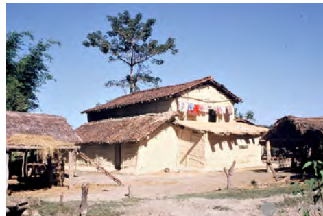
Maison tharu du terai. Source : www.flickr.com/nepal architecture
