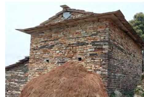
Large débord de toiture d'une maison magar.
