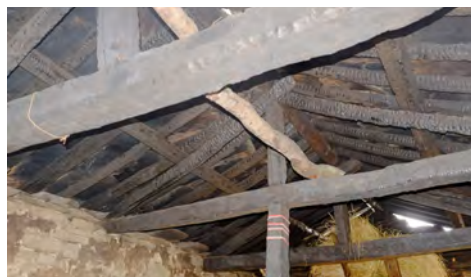
Charpente de bois ayant subi un fumage indirect.
