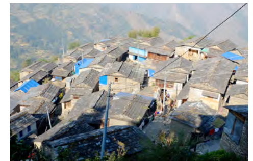
Recours de plus en plus important de la tôle comme matériau de couverture et de bardage.
