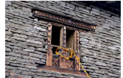
Détail d'une fenêtre richement décorée.
