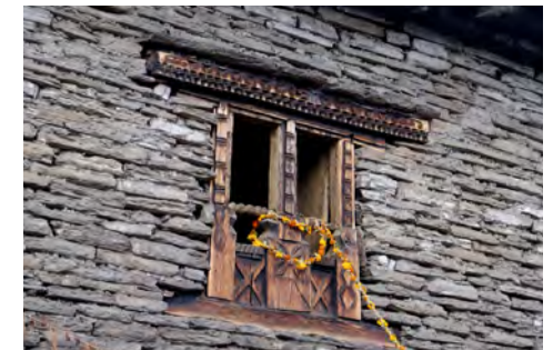
Détail d'une fenêtre richement décorée.
