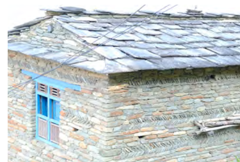
Maçonnerie en pierre et terre comportant un appareillage en arête de poisson et un chaînage d'angle.
