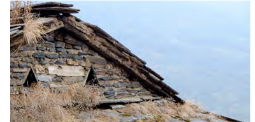
Pignon percé d'ouvertures triangulaires assurant la ventilation du comble et l'entrée de lumière.
