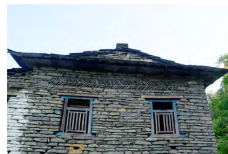
Ouvertures en bois incrustées dans un mur pignon.
