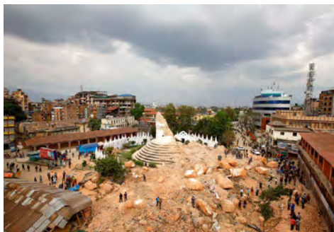
La tour historique de Dharhara après son effondrement.
