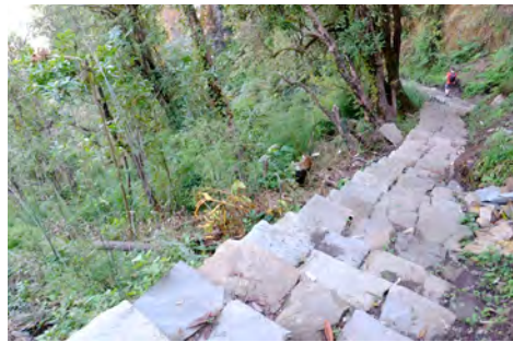
Escalier en pierre ponctuant régulièrement les chemins de l'ADCE Trek.
