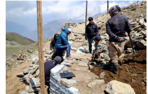
Visite du chantier par les membres de LCDM lors de la réalisation des murs de soutènement.
