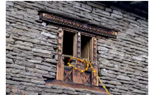
Détail d'une fenêtre richement décorée.
