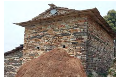
Large débord de toiture d'une maison magar.
