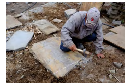
Taille d'une pierre plate à l'aide d'un tuktuke .
