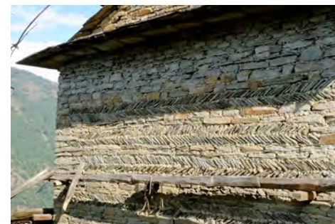
Succession d'appareillages en arête de poisson.
