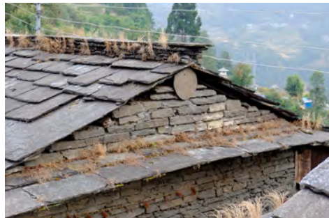
Pierre ronde recouvrant la section de la panne faîtière.
