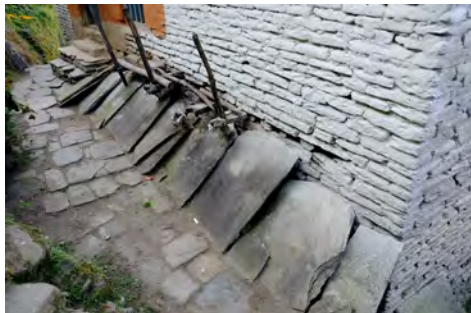
Rangée de pierres disposées le long d'un mur pour le protéger de la pluie.
