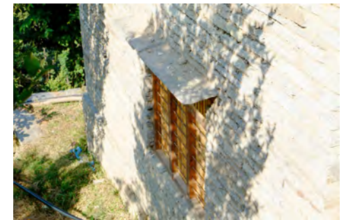
Casquette en pierre au-dessus d'une ouverture.
