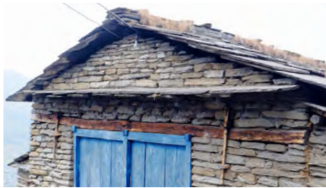
L'auvent de la toiture en pierre permet la partition du mur pignon.
