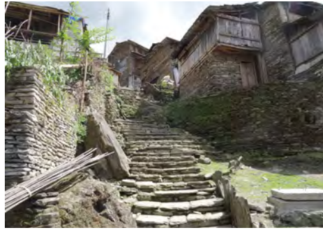
Vue des espaces extérieurs du village avec ses ruelles et ses terrasses en pierre.
