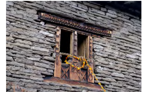
Détail d'une fenêtre richement décorée.
