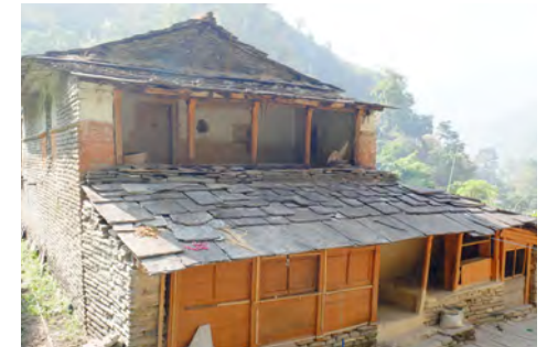
Typologie actuelle des maisons magars : forme rectangulaire, toiture en pierre et présence d'extensions.
