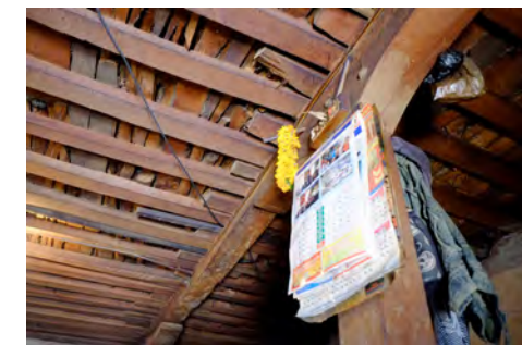
Solivage supportant un lattis en bois d'un plancher intérieur.
