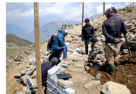
Construction d'un mur de soutènement sur le site de Khopra.
