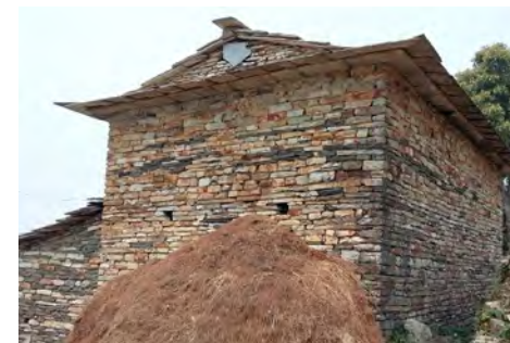
Large débord de toiture d'une maison magar.
