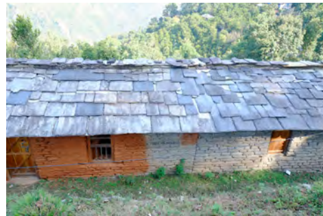
Dalles de pierre posées par recouvrement.
