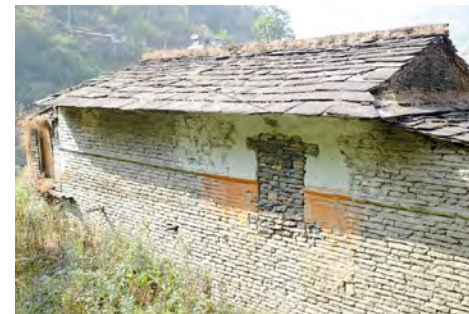
Lit de grandes dalles en pierre apportant une meilleure résistance au mur.
