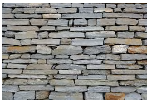
Mur en pierre sèche.
