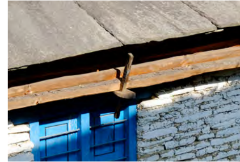
Inclusion en bois dans la maçonnerie permettant la création d'un support extérieur.
