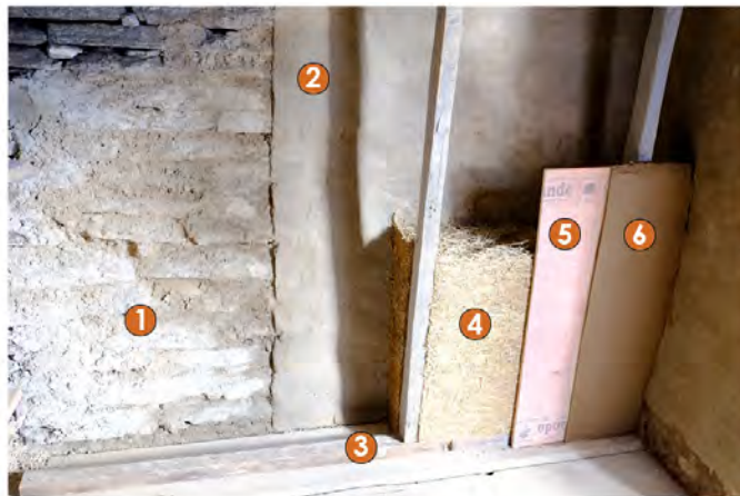
Test du principe d'isolation d'un mur en pierre sèche réalisé sur site.
