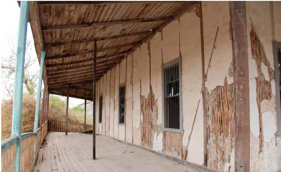
Construction en torchis de cagne à la Quebrada de Tarapacá
