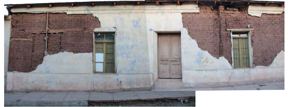
En haut, maison après le tremblement de terre de 2015, avec dommages générée par l'eau et témoigne par le mouvement sismique En bas, état actuel dans le centre ville de Combarlabá. Photo de février 2016
