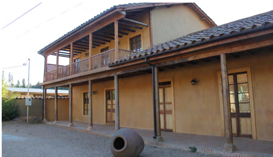
Même maison après les réparations et enduit en terre. 2016
