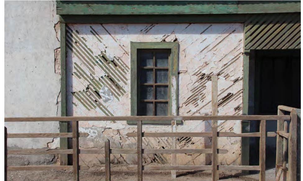
Construction en torchis remplis avec caliche dans la salitrera Humberstone
