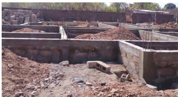
Le mur de fondation est érigé avec des agglos pleins de 20 cm d'épaisseur, posés sur du béton de propriété de 5 cm dans une fouille en rigoles de 40 cm d'épaisseur et une profondeur de 40 cm. Les semelles des poteaux sont également en béton armé de 80 cm \* 80 cm avec une épaisseur de 20 cm. La fondation peut avoir une hauteur de 80 cm couronnée par une longrine en béton armé permettant de ceinturer l'ensemble.
