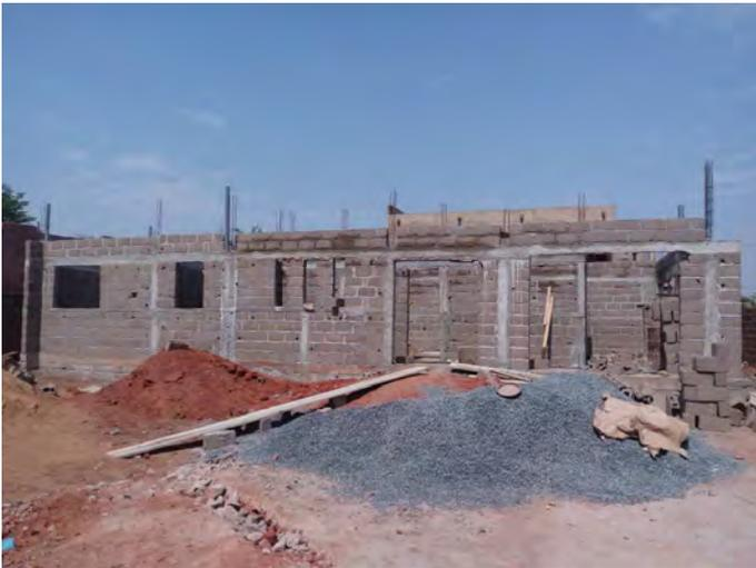
La maçonnerie en élévation est faite avec des agglos creux de 15, tenus par des poteaux et chainages linteaux en béton armé. La hauteur sous plafond est de 3.2m.
