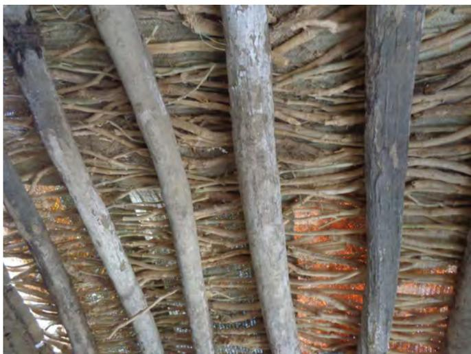
La couverture est faite en terre et se repose sur les murs porteurs qui transmettent les charges sur le sol. Elle est constituée par une structure en bois de rônier, posée sur les murs dans le sens de la largeur avec un espacement de 50 cm que contient les perchettes en bois « Gaulettes » sur lesquelles sont posées de nattes végétales qui reçoivent la terre de couverture d'une épaisseur de 15 cm.
