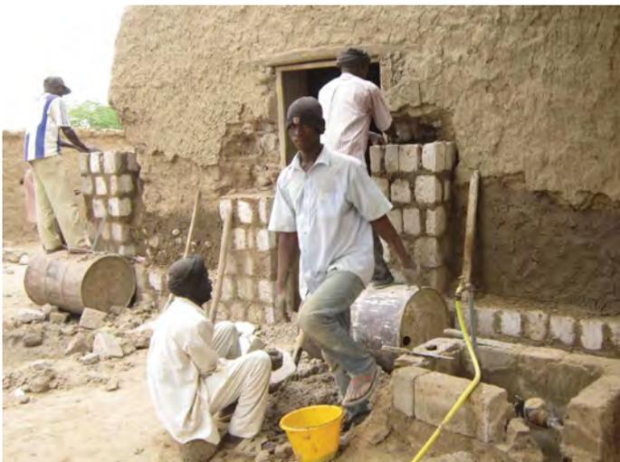
mur en terre pour le revêtement. Les pierres sont taillées pour donner une forme carrée et sont ensuite rejointoyés avec un mortier de ciment.
