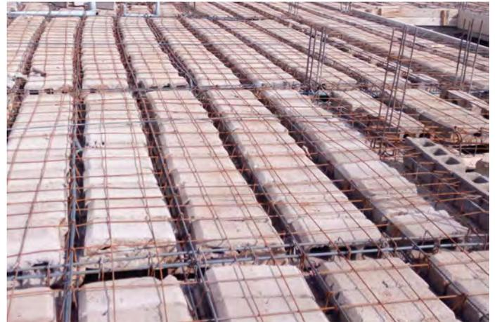
La toiture est également construite en béton armé, constituée par un assemblage d'hourdis et de ferrillages permettant de soutenir la dalle de compression de 5 cm d'épaisseur en béton armé dosé à 350 kg/m<sup>3</sup>.
