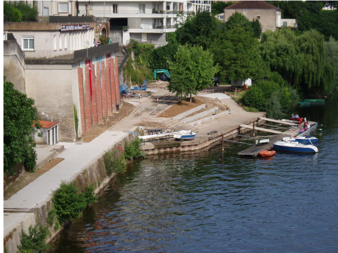
Travaux d'aménagement d'une promenade le long du Lot, Villeneuve-sur-Lot, rive gauche source : Raphaël VERA, enquête de terrain (27 mai 2018)
