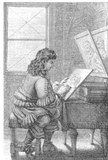
Châssis garni de deux carreaux de papier huilé (J.-F. Belhoste et G.-M. Leproux, « La fenêtre parisienne aux XVIIe et XVIIIe siècles »)
