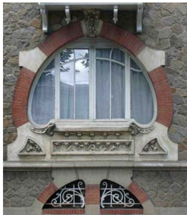
(44) NANTES, Villa Jeannette Détail fenêtre d'une Villa de style Art Nouveau construite en 1907 par F. Ménéard et E. le Bot.
