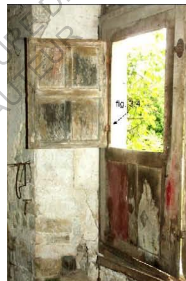
(50) Région de CARENTAN Manoir, 2ème quart du XVIe s. Traces de peinture sur les compartiments supérieur et inférieur (A. Tiercelin, étude n°50003, chassis-fenêtres.info)
