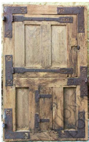
(72) Région du MANS Édifice inconnu, 1er quart du XVI e s. Ici les pentures à charnière sont reliées à des équerres, obtenant ce double rôle de consolidation et de rotation. (A. Tiercelin, étude n°72003 , chassis-fenêtres.info )
