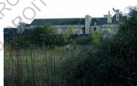
Vision de l'hôpital en passant le muret
