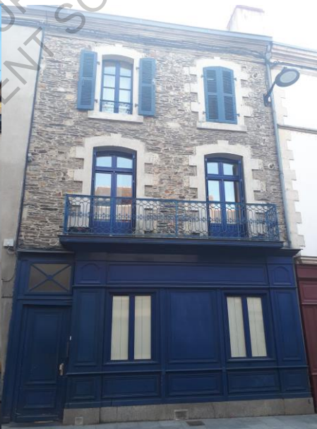
Ancien magasin de chaussures GALLON
