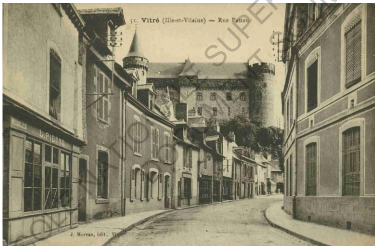
Rue Pasteur avant.
