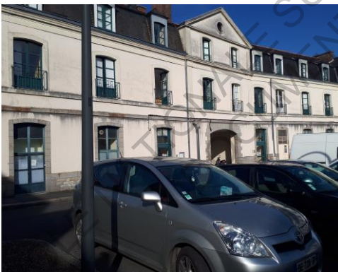
Ancienne hôpital St Nicolas, vue depuis la cour intérieure.
