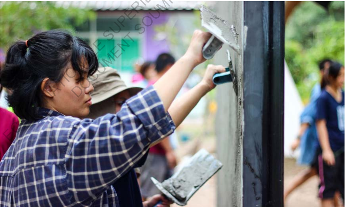
Recouvrement des parpaings avec un enduit ciment lissé à la taloche.
