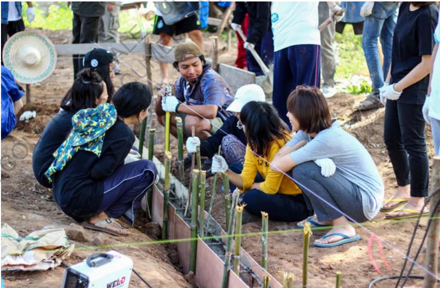
Vibrage du béton à l'aide de petites tiges métalliques ou de bambous fins
