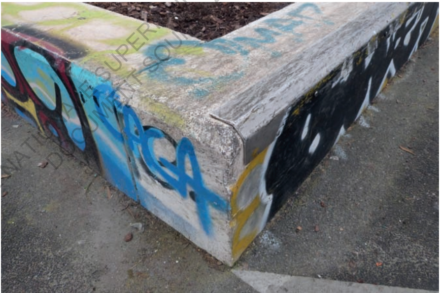
Cornières métalliques installées par la ville, pour la protection du muret.
