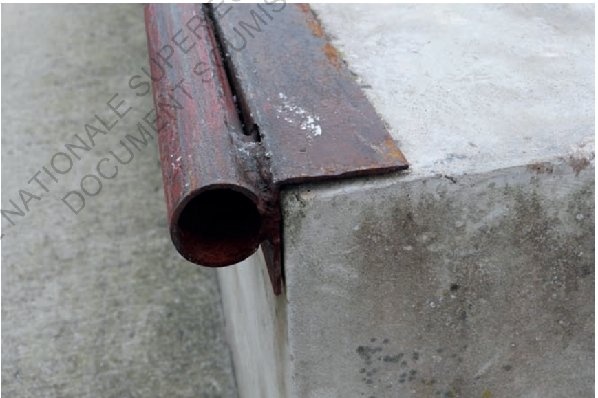
Un soin apporté au spot : une cornière en métal, puis une barre ont été fixés au muret de béton.
