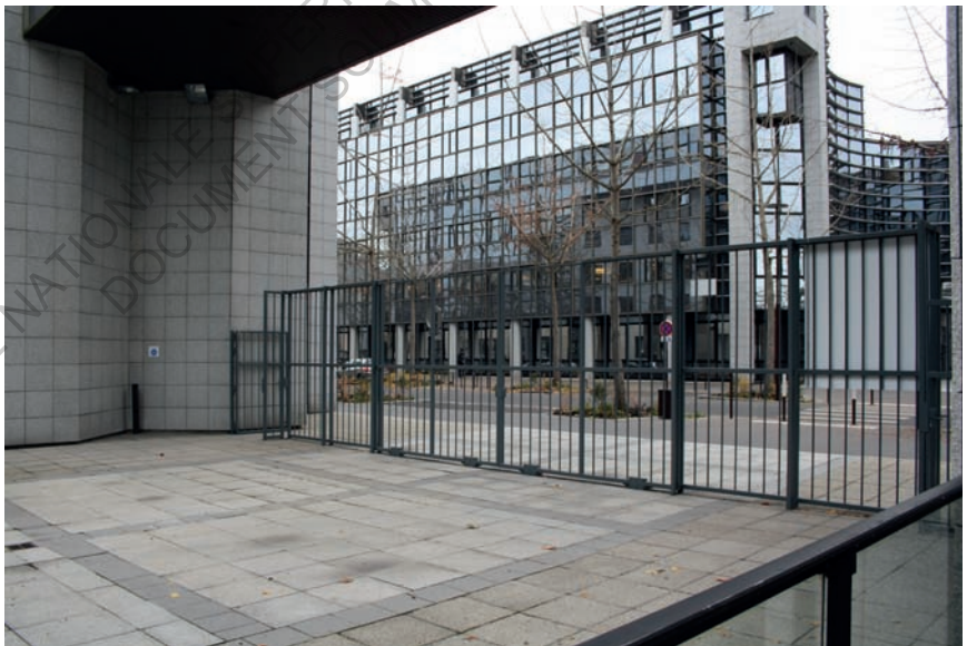
Sécurisé par une barrière à escalader.
