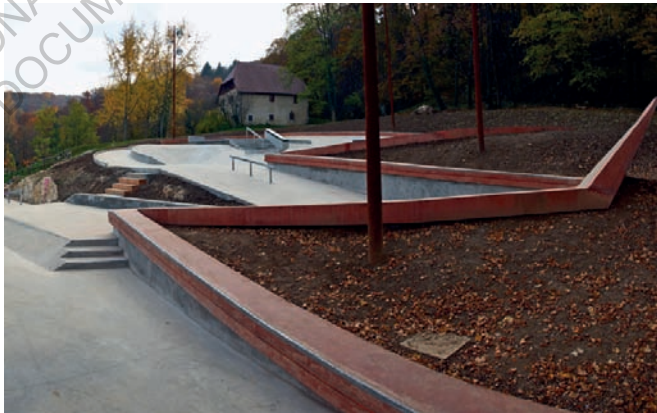
Skatepark d'Annecy construit en 2008 par l'agence Constructo. Photo : Constructo
