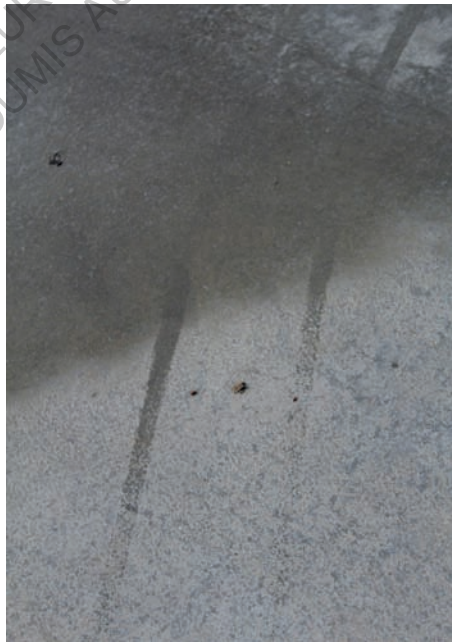
Surface de roulement encore humide : une connaissance fine des matériaux et de leurs caractéristique physiques.
