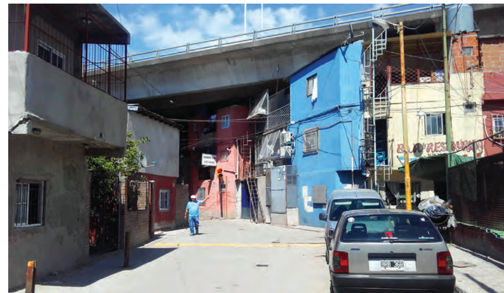
Figure 3 : Escalier de colimasson au barrio Bajo de Autopista, villa 31, octobre 2018. Photo personnelle
