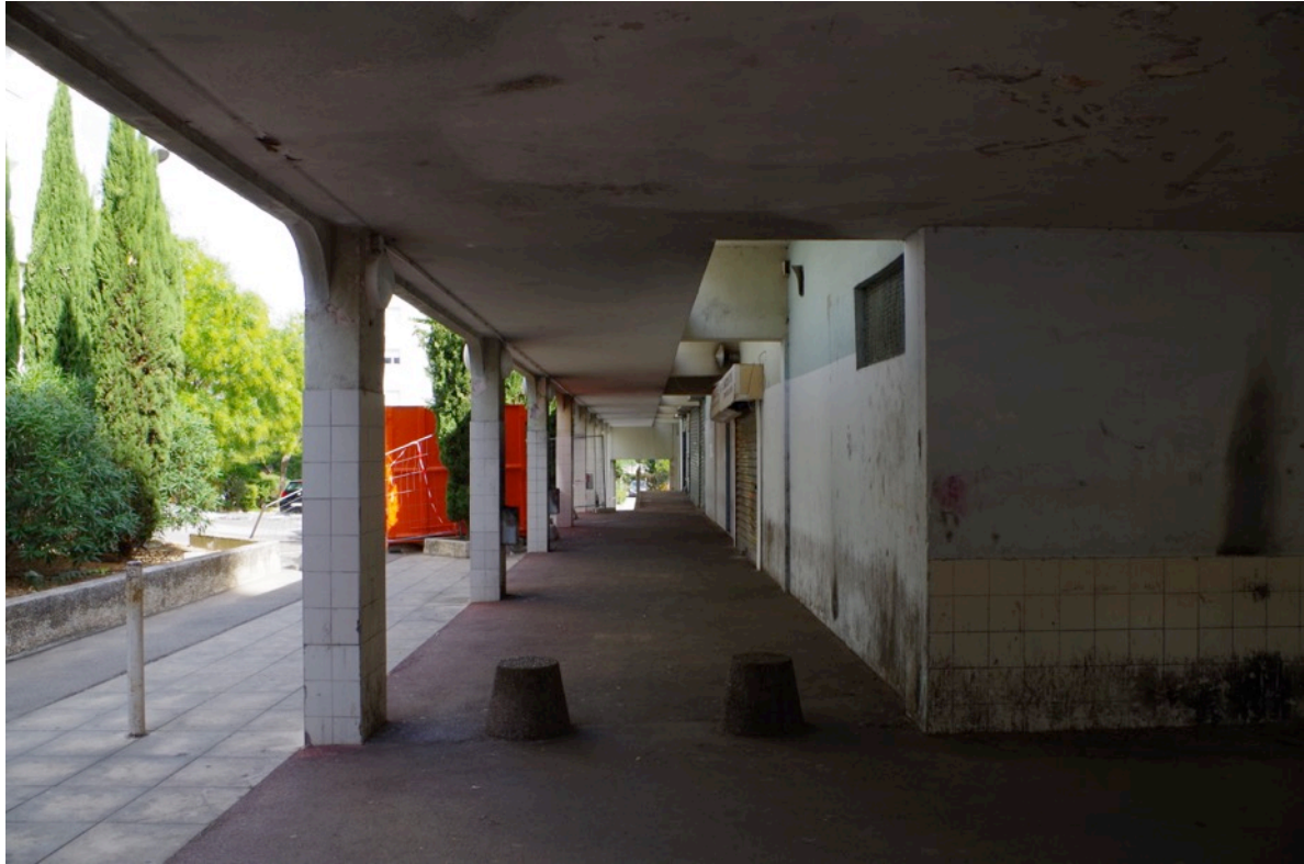
Figure 7 : centre commercial du Charrel avant travaux
