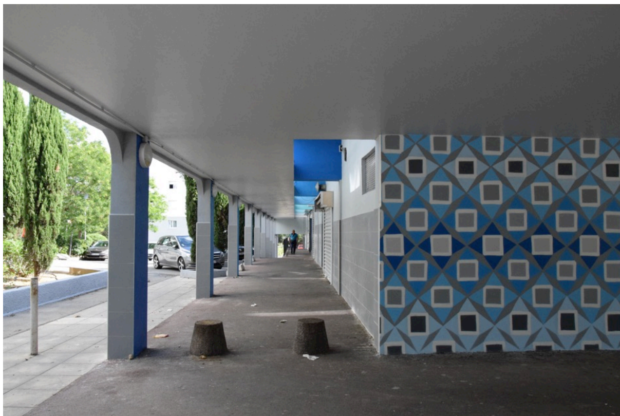
Figure 8 : Centre commercial du Charrel après travaux
