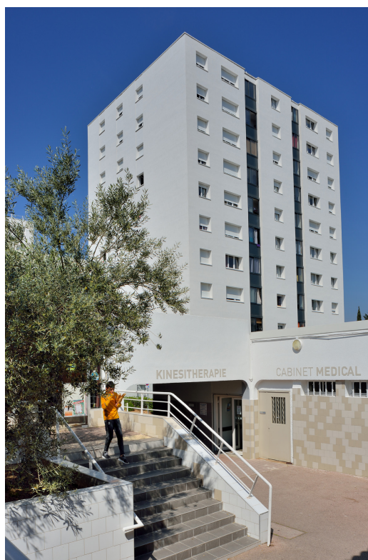
Figure 13 : Le Charrel après travaux en 2016, Baldassari-Sibourg architectes
