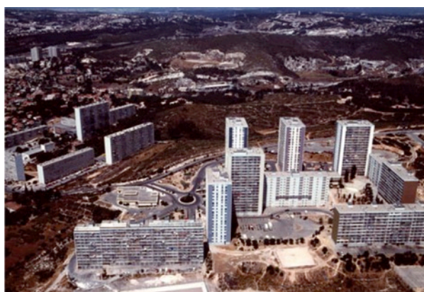
Le site avant démolition des bâtiments J et M (doc. SNHLM).
