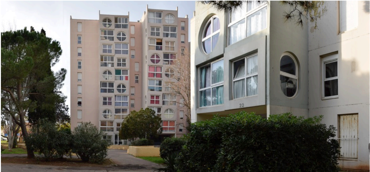
Figure 14 : photo de la résidence Salvador Allende à Port-Saint-Louis-du-Rhône avant travaux
