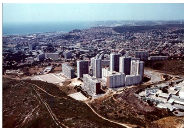
Le site avant démolition – Vue sur la rade de Marseille (doc. SNHLM).
