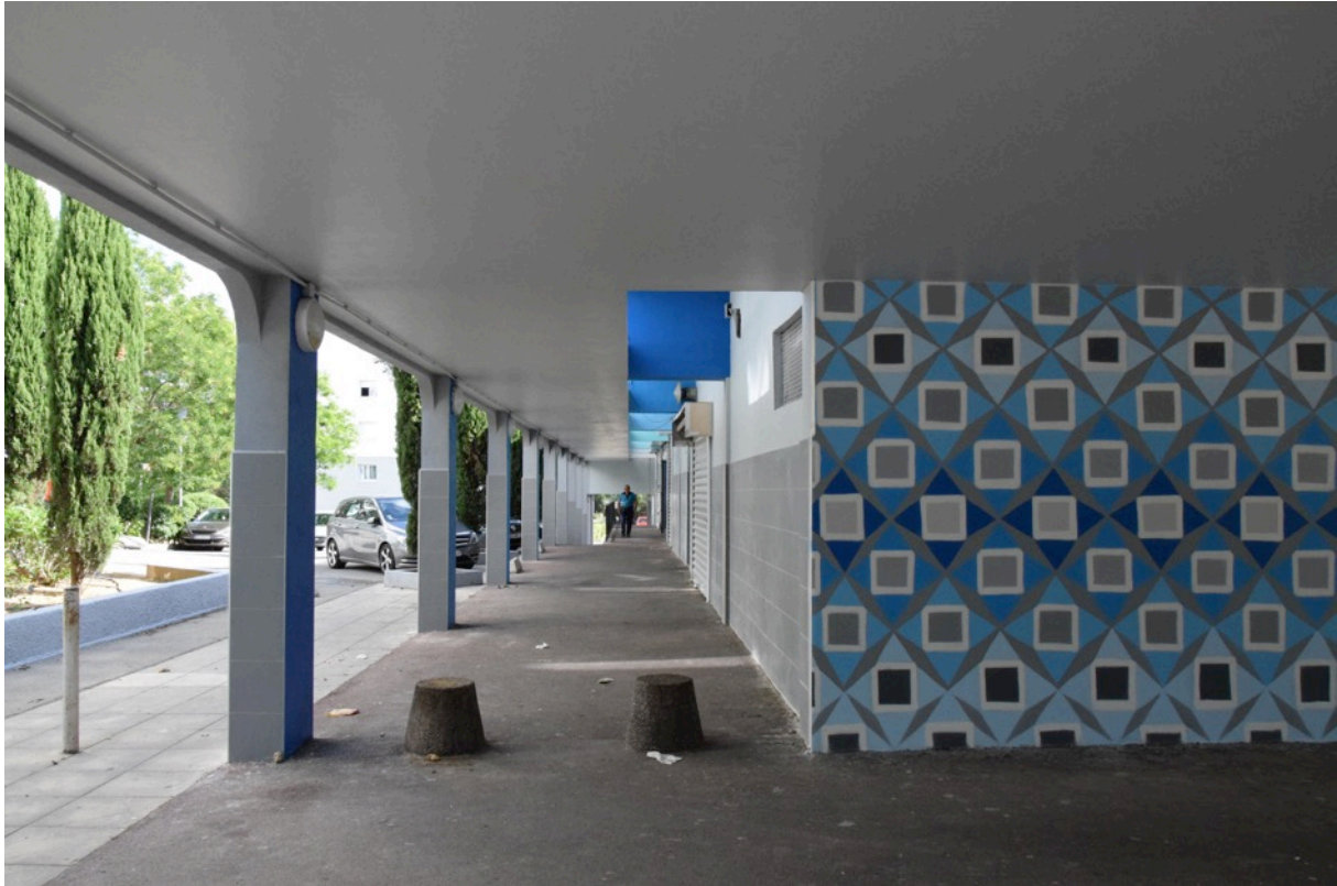
Figure 8 : Centre commercial du Charrel après travaux
