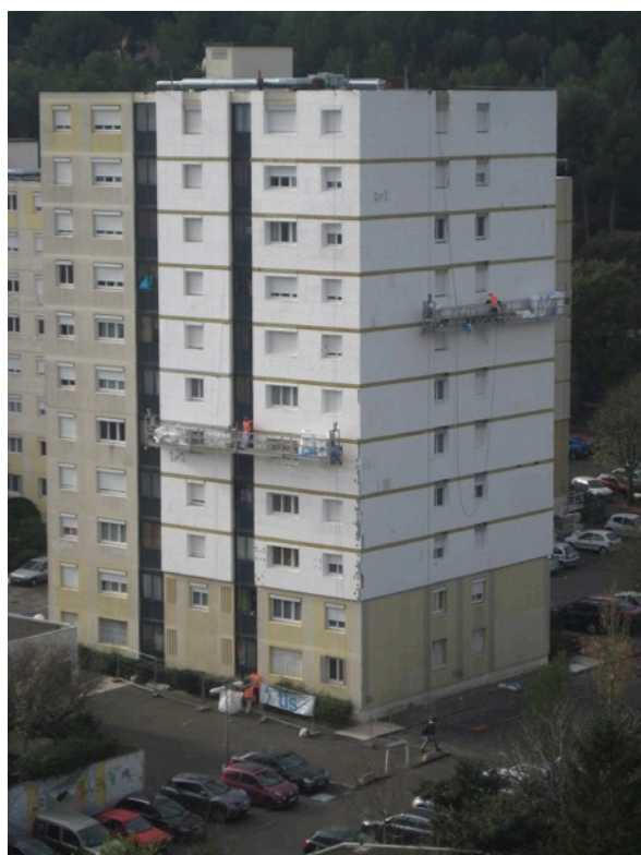
Figure 13 : Photo du Charrel en chantier en 2014, Baldassari-Sibourg Architectes
