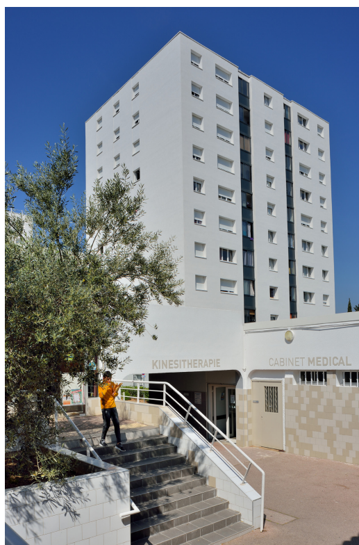
Figure 13 : Le Charrel après travaux en 2016, Baldassari-Sibourg architectes
