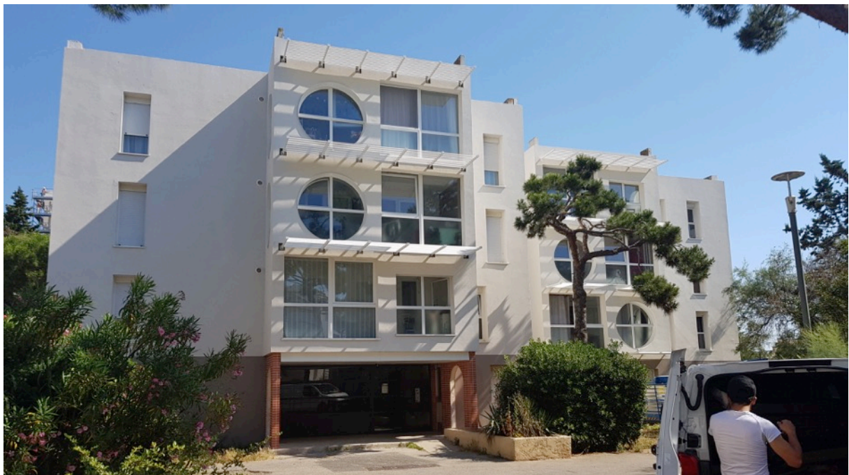
Figure 16 : Résidence Salvador Allende, Port-Saint-Louis-du-Rhône en travaux (septembre 2018) Baldassari-Sibourg Architectes
