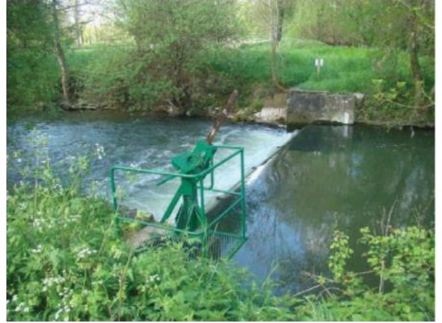
Figure 12 : Clapet du moulin de La Roche (SABV)
