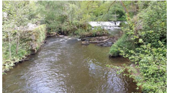
Figure 21 : Ancien seuil du moulin de Soumagnac Source : PNR
