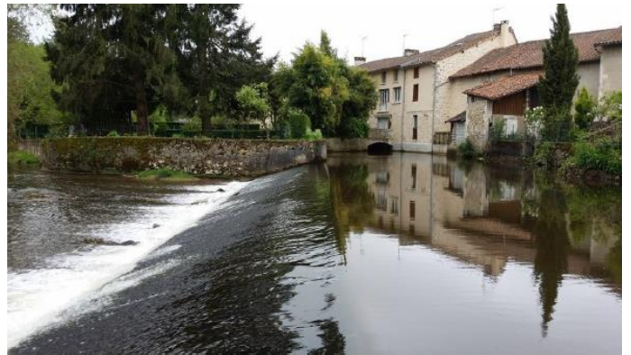
Figure 26 : seuil avant travaux Source : PNR
