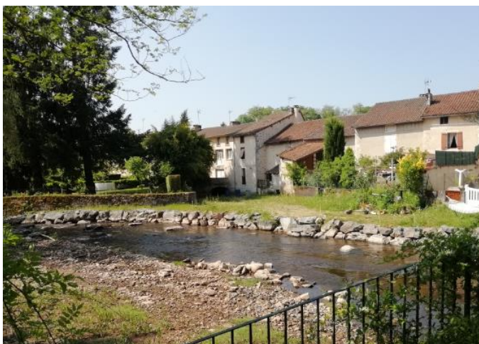
Figure 30 : Emplacement du seuil après travaux
