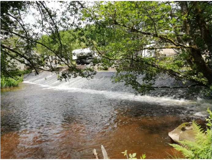
Figure 32 : Seuil du moulin Grandcoing
