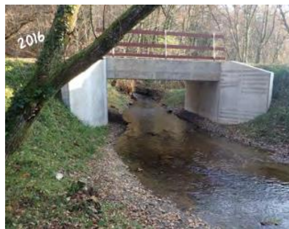
Figure 4: Pont cadre après restauration en 2016 (source : PNR Péroigord-Limousin, 2017)
