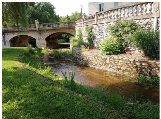
Figure 29 : Bras d'eau après travaux
