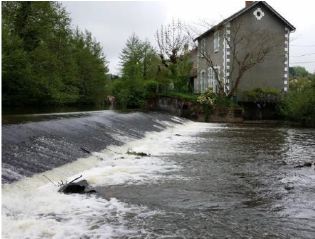
Figure 27 : L'usine et son seuil avant travaux Sources : PNR
