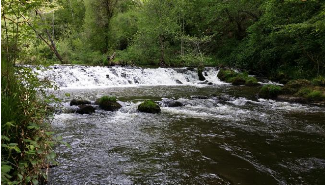
Figure 22 : Ancien seuil du moulin de Soumagnac Source : PNR
