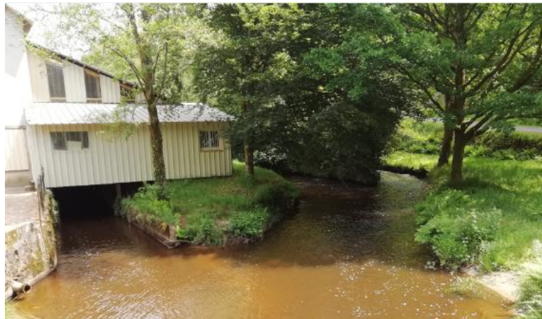
Figure 33 : Aval du seuil du moulin Grandcoing
