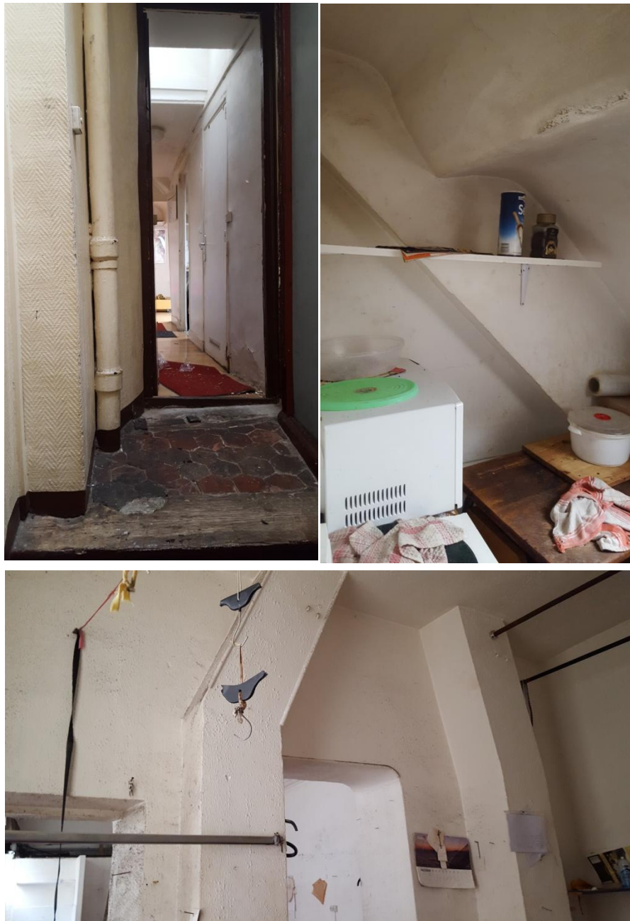
Figure 13 : photos de l'ensemble immobilier, prises par l'auteur.
