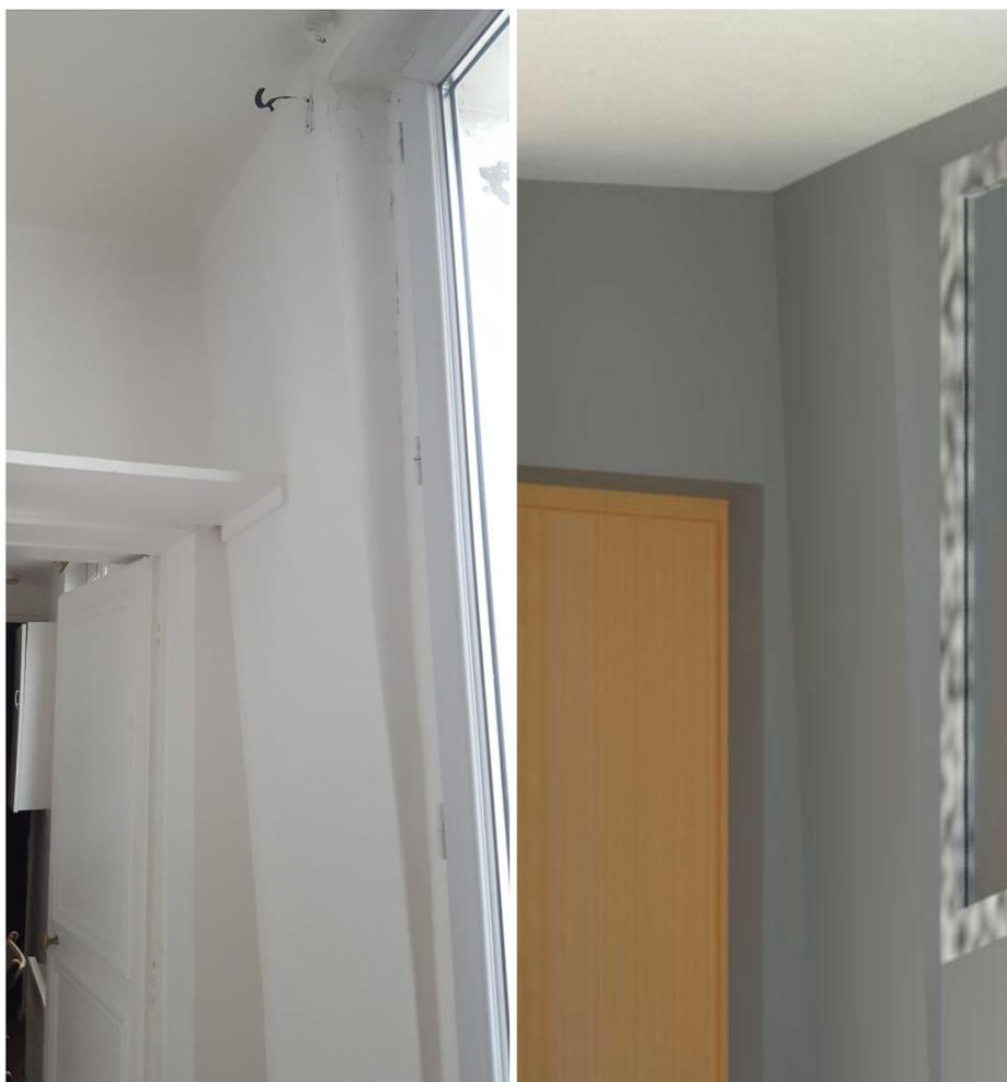
Figure 17 : photo (à gauche) et modélisation (à droite) d'un mur avec contre-fruit.
