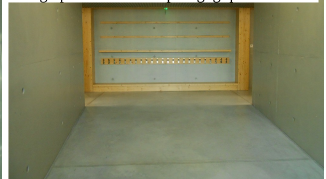
Photographie 5.9 : Espace de circulation au rez-de-chaussé et porte-manteaux.
