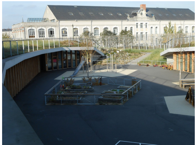
Photographie 5.3 : Vue depuis la cour de l'étage
