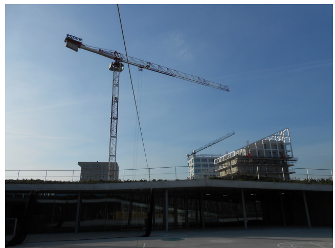
Photographie 5.4 : Contrechamp depuis la cour sur les immeubles.
