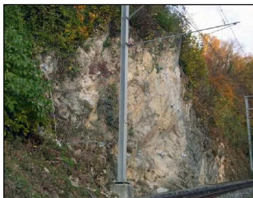
Figure 10 : Rocher de Toveyres, présence d'un treillis métallique plaqué et cloué
