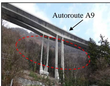
Figure 4 : Falaise de Veytaux Source : personnelle - Date de prise de vue : 2018.02.21
