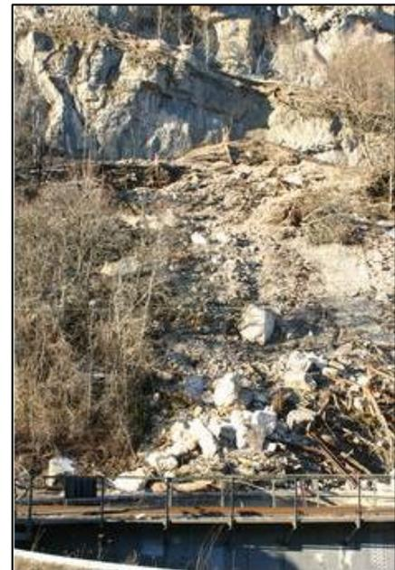
Figure 2 : Exemple d'un éboulement sur la plaque tournante CFF à Vallorbe, Décembre 2010.
