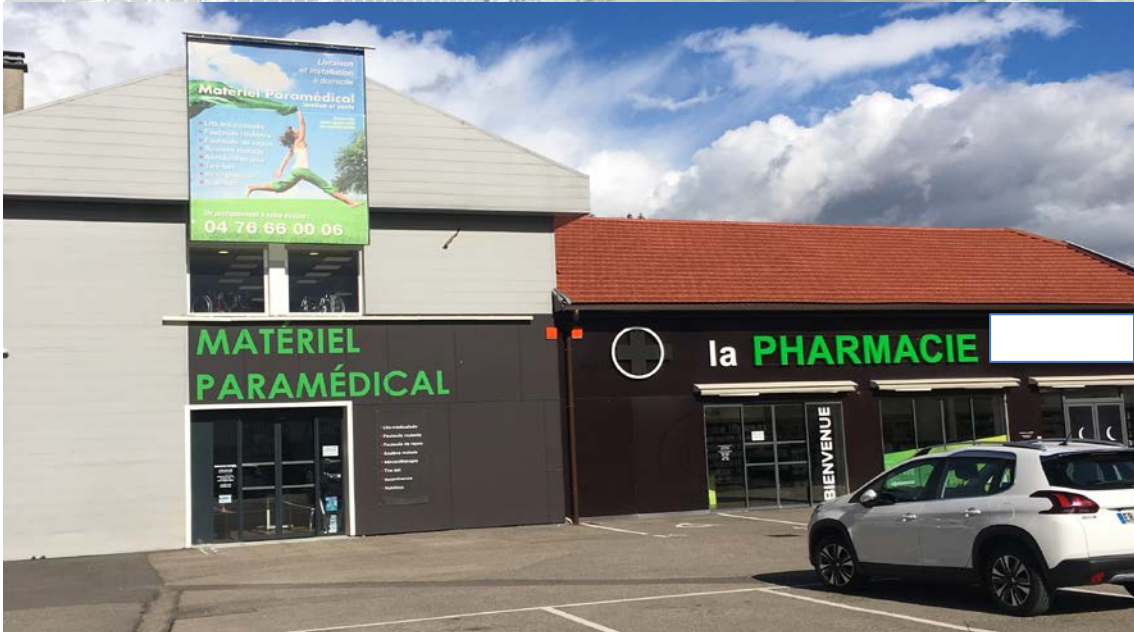
Figure 11 : Pharmacie vue de l'extérieur avant travaux, le projet et après travaux
