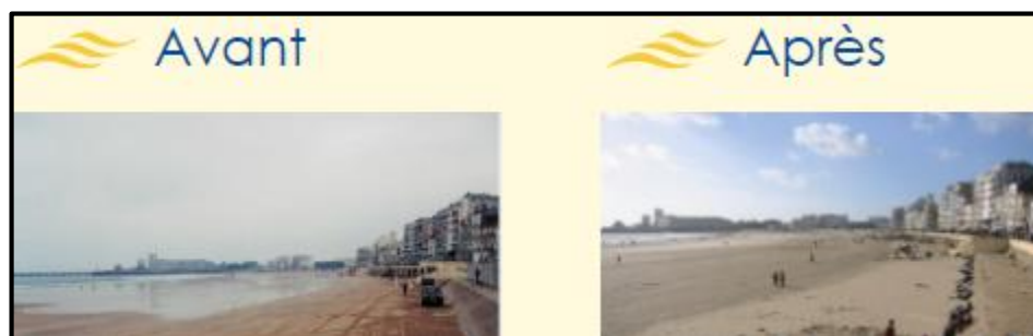
Figure 21 : La Grande Plage des Sables-d'Olonne : à gauche, avant la pose du drain et à droite, après la pose du drain (source : ecoplage.fr)
