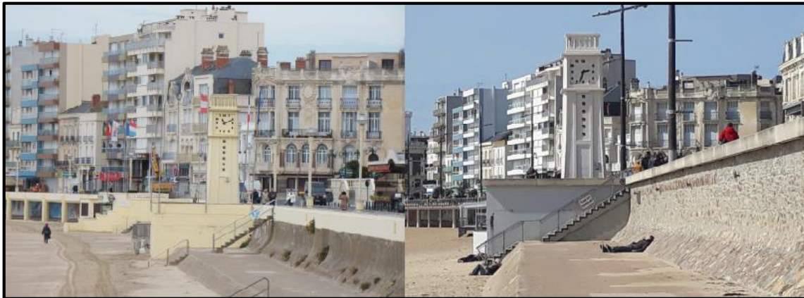
Figure 25 : Le remblai des Sables-d'Olonne : à gauche, avant travaux en 2010 et à droite, après travaux de 2013 (clichés : S. Berthome 2010 et F.Vendrin 2018)
