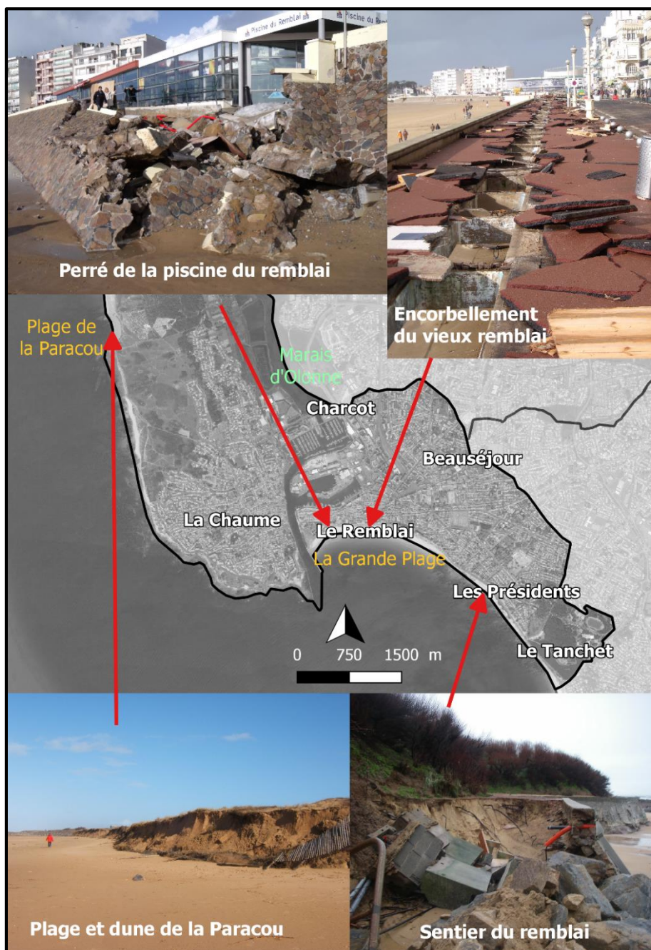
Figure 23 : Quelques dégâts de la tempête Xynthia de février 2010 sur la côte sablaise (source : DST des Sables-d'Olonne, conception F.Vendrin 2018)
