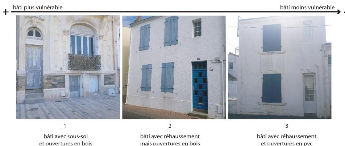
Figure 46 : Typologie simplifiée de la vulnérabilité de la structure du bâti aux Sables-d'Olonne (clichés et conception : F.Vendrin avril 2018)
