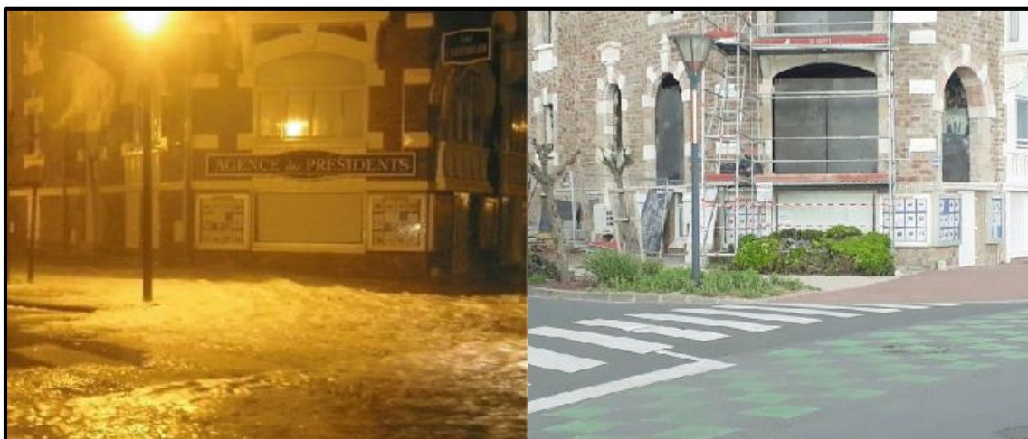
Figure 40 : L'agence immobilière sur la promenade Georges Godet du remblai : à gauche pendant la tempête Xynthia et à droite en temps normal (clichés : DST, 2010 et F.Vendrin 2018)
