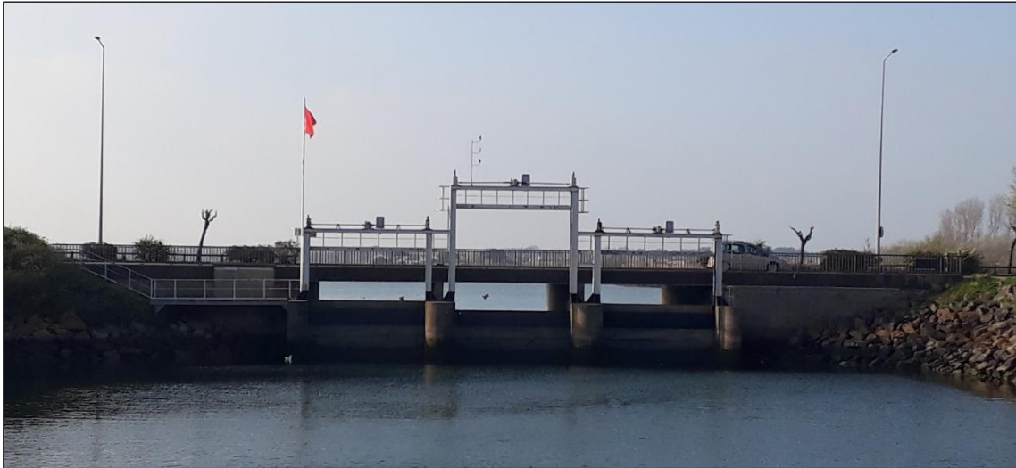
Figure 35 : L'écluse de la rocade en direction des marais d'Olonne depuis le quai de l'Amiral de la Gravière aux Sables-d'Olonne (cliché : F.Vendrin 2018)
