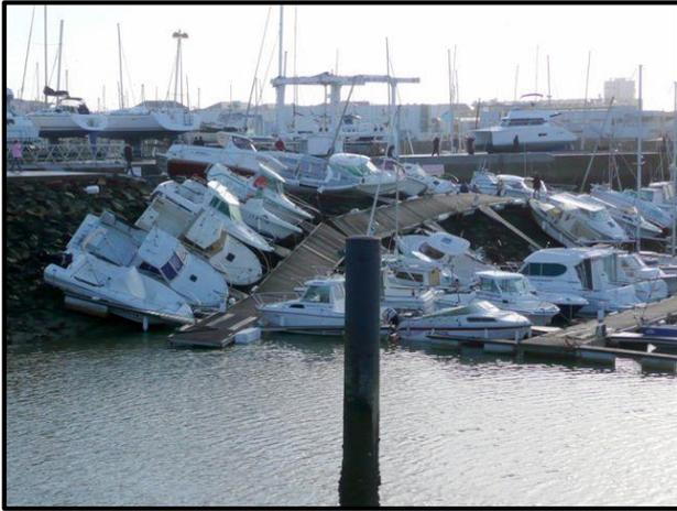
Figure 24 : Pontons et bateaux renversés dans le port de plaisance des Sables-d'Olonne après la tempête Xynthia (cliché : J. Congal, 2010)
