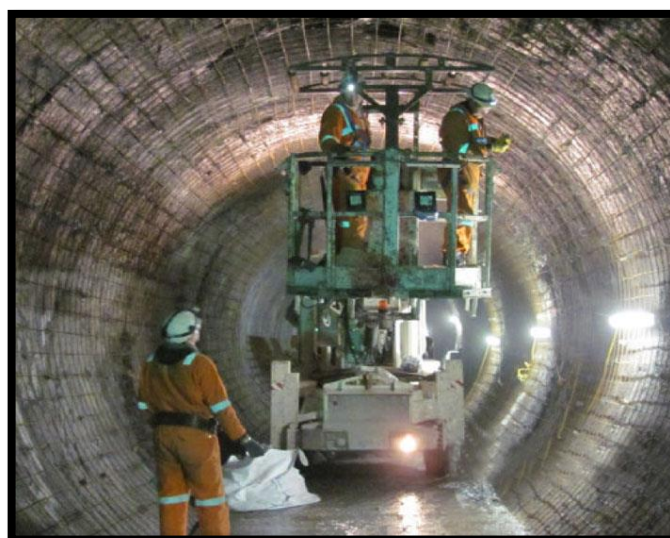
Figure 2-7 : ouvriers travaillant en souterrain, activité professionnelle hautement exposée aux émissions diesel
