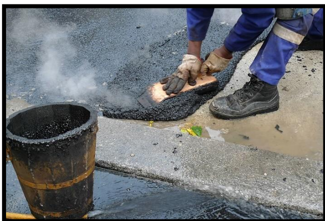
Figure 2-10 : les couvreurs peuvent être exposés aux vapeurs de HAP en mélange lors de la pose de goudron d'étanchéité
