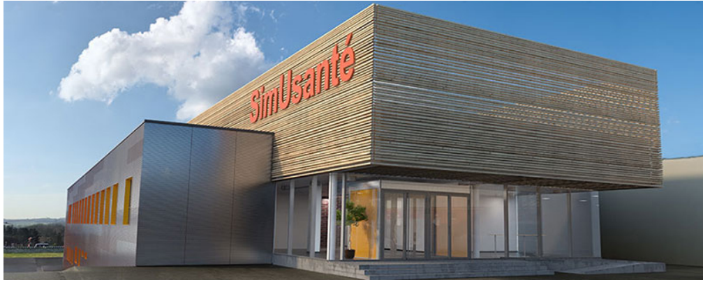
Figure 7 : centre de formation SimUsanté à Amiens. (Photographie du site web)
