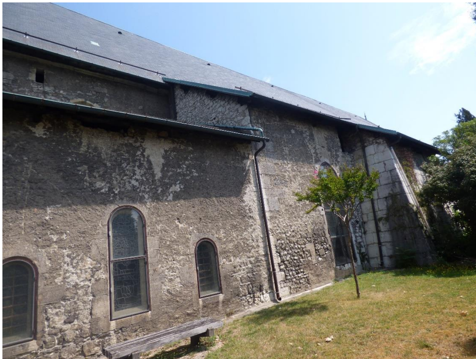
Fig. 17 – Église Saint-Pierre de Lémenc, Chambéry (Savoie), façade sud
