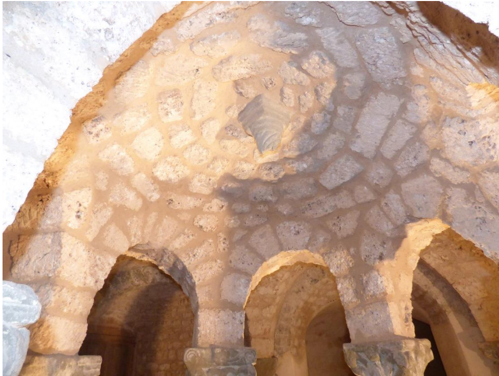
Fig. 29 – Église Saint-Pierre de Lémenc, Chambéry (Savoie), coupole avec sa clé de voûte pendante
