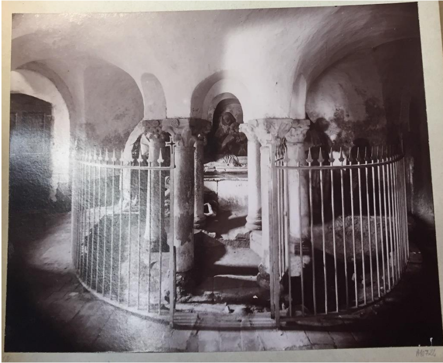
Fig. 45 – Photo de la rotonde, grille de protection
