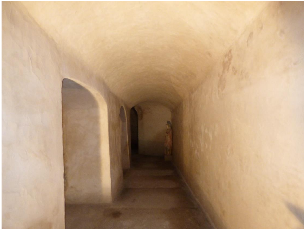
Fig. 46 – Église Saint-Pierre de Lémenc, Chambéry (Savoie), collatéral nord recouvert d’enduit
