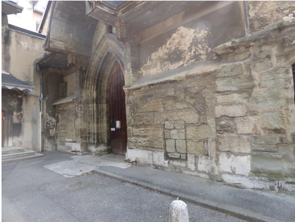
Fig. 16 – Église Saint-Pierre de Lémenc, Chambéry (Savoie), détail de la façade occidentale
