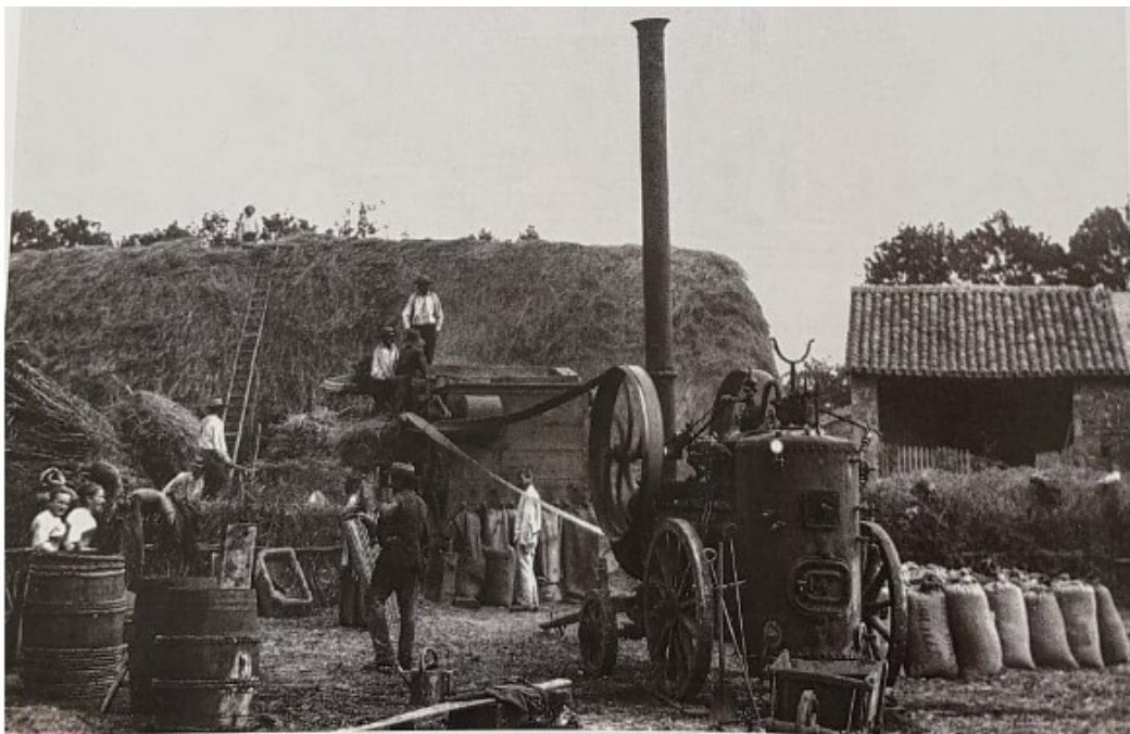
Doc. 5 Une batteuse et sa chaudière à vapeur
