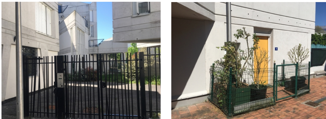
deux exemples de résidentialisation dans le quartier Renaudie, Saint-Martin-d'Hères, avril 2018, Holly Helfrich
