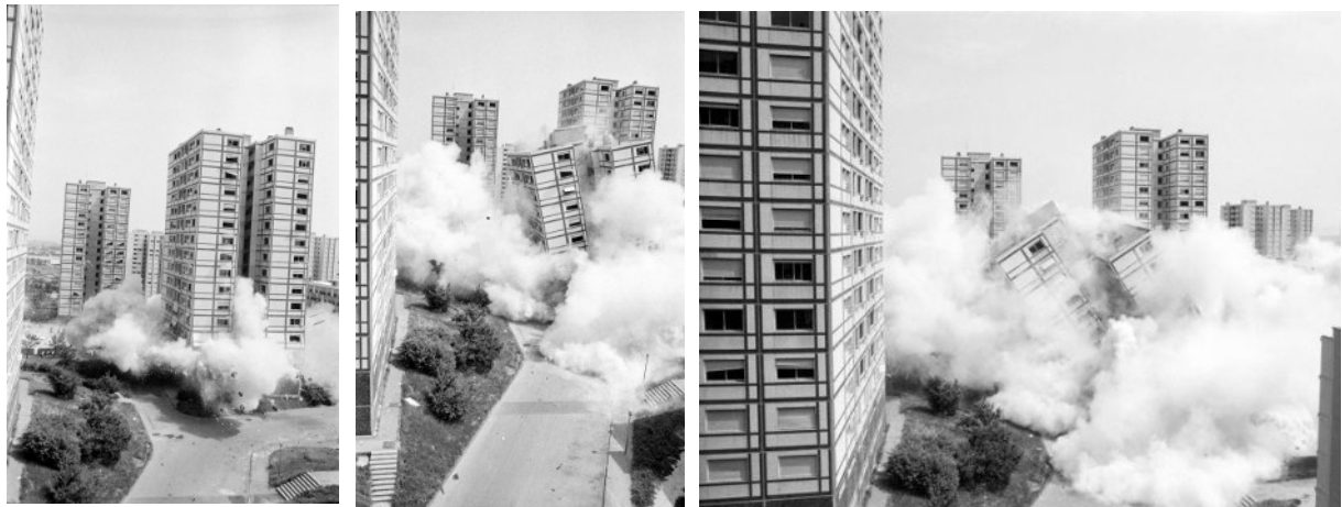
Démolition de la Tour 6 des Minguettes à Vénissieux, LyonFigaro, 1983-06-09, Lyon (Rhône).
