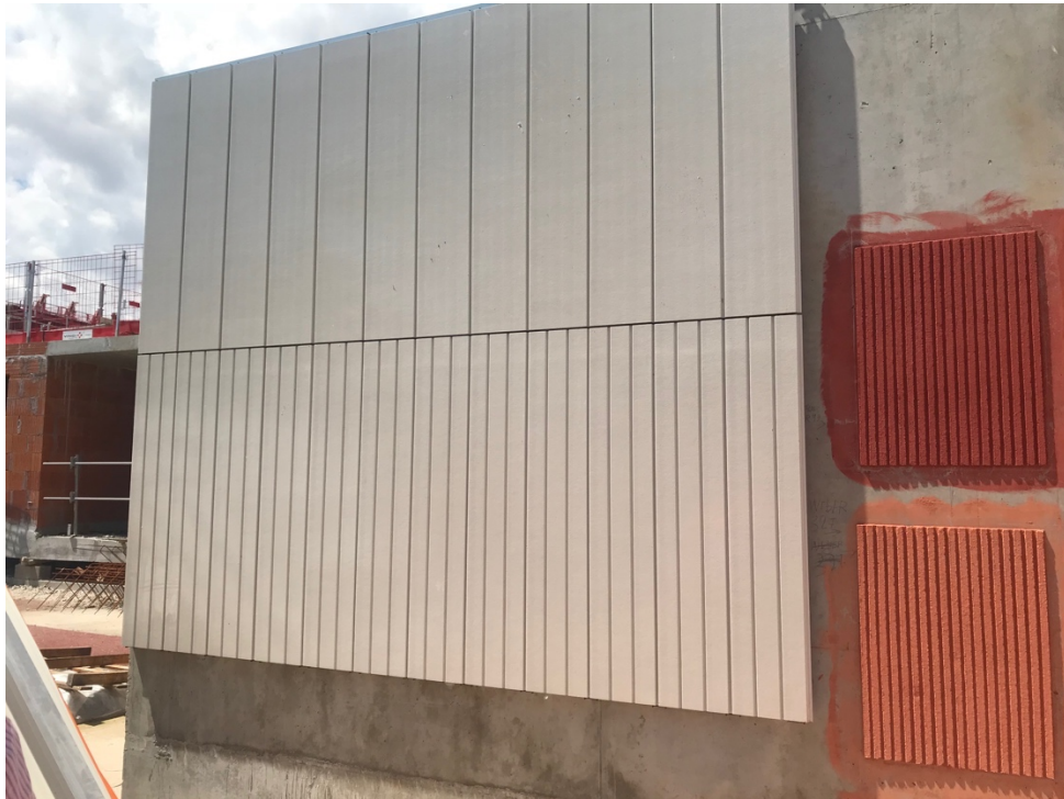
Figure 38 : Prototype finaux de façade en céramique
