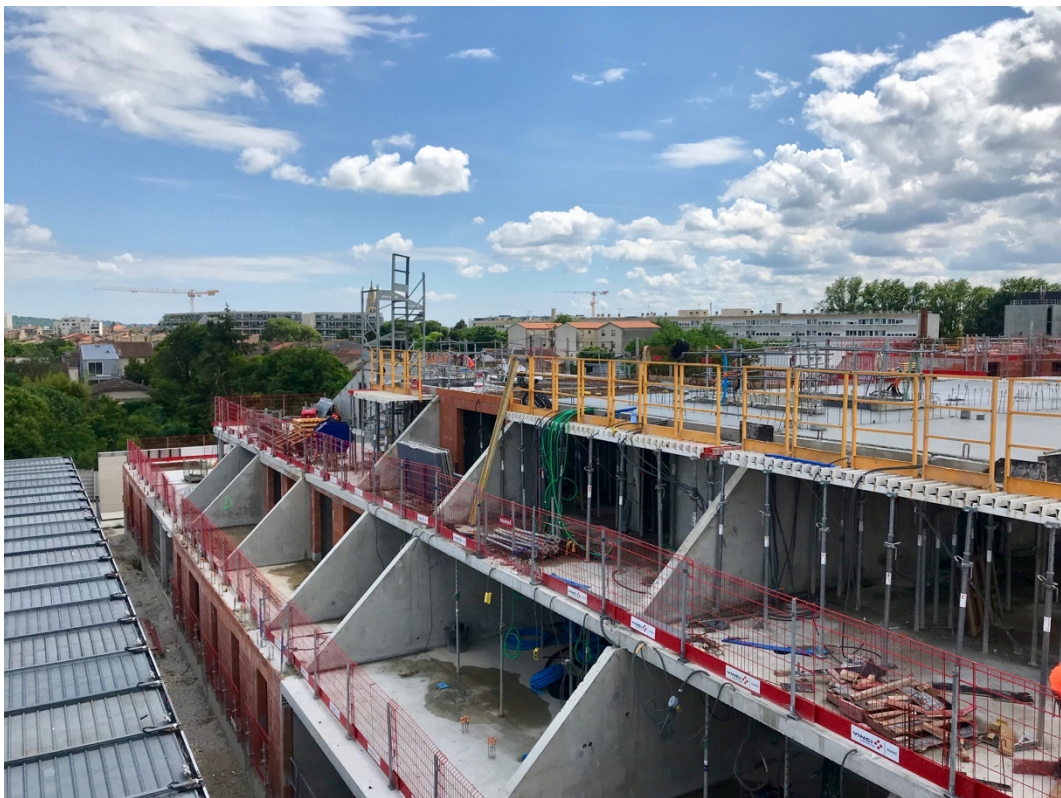
Figure 39 : Avancement du chantier lors du dernier contrôle des prototypes
