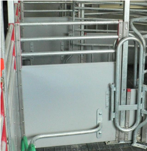
Figure 19: Surélévation des parois PVC par des barres métalliques avec plus de trois barres. © PITOLLAT M, Elevage inconnu, 2018.
