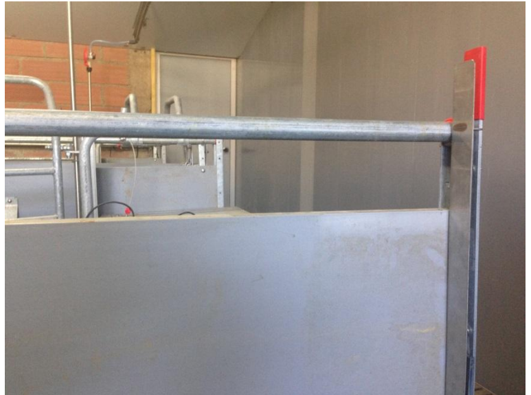
Figure 20: Surélévation des parois PVC avec une seule barre métallique. © RANNOU G, Elevage adhérent, 2018.
