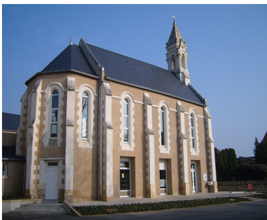
Illustration 4: Vue d'extérieur de la Chapelle (anciens locaux de la bibliothèque de Mazé)
