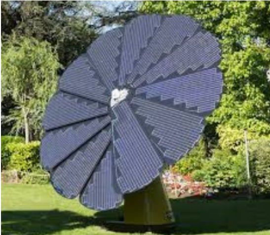
Figure 37 : La Smartflower copie la nature (biomimétisme) en agissant comme un tournesol pour améliorer sa productivité. Source : EDF- Smartflower
